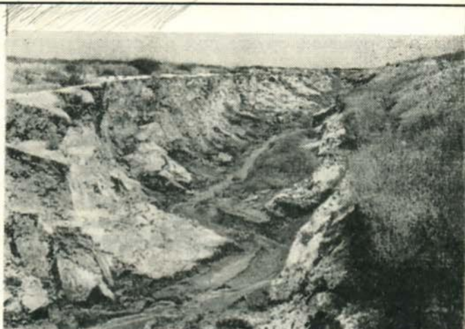
1 Обрушение коллектора
