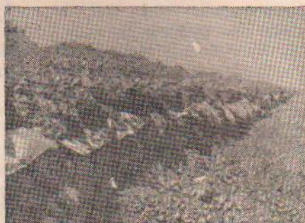
2 Канал ПР-1-4-1. Пленочное покрытие повреждено при очистке канала экскаватором
