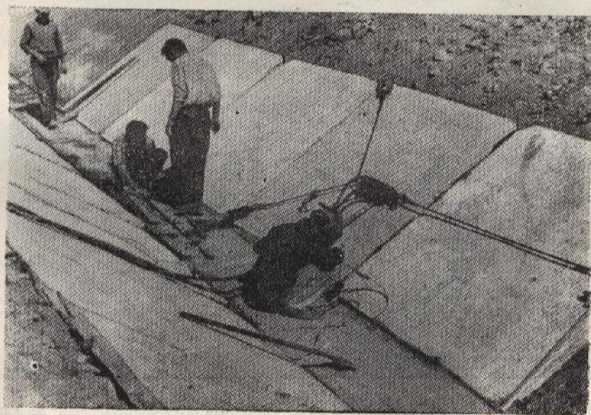
Рис. 16. Стягивание плит силовыми цилиндрами на канале 5-1-Х.
