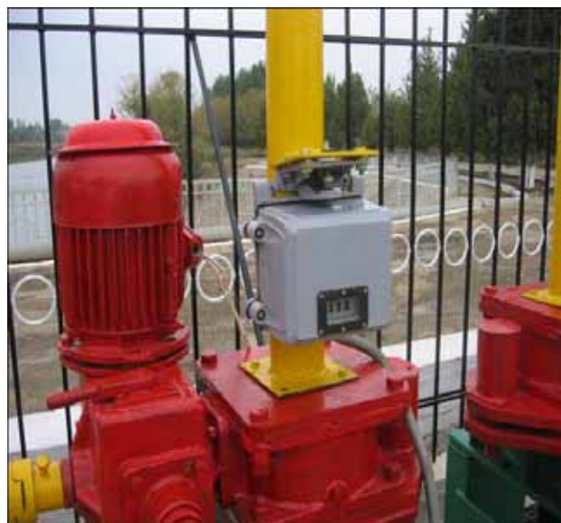
Рис. 6. Установка ДПЗ на винт затвора
