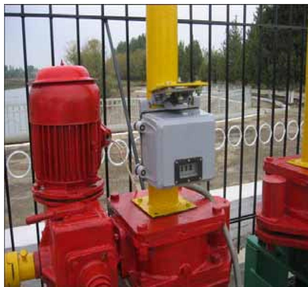
Рис. 6. Установка ДПЗ на винт затвора
