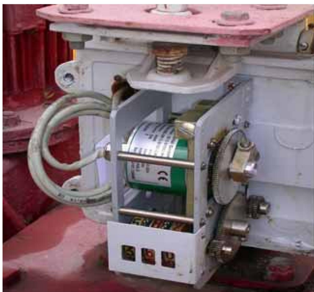
Рис. 5. Датчик положения затвора (ДПЗ)
