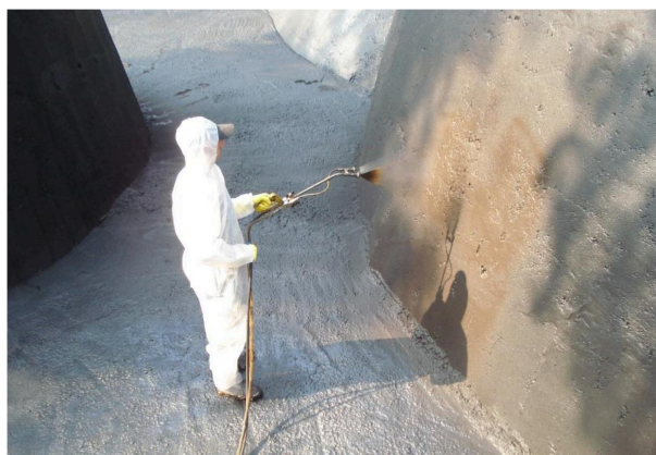
Рисунок 2 – Напыление жидкой резины на оросительном канале
