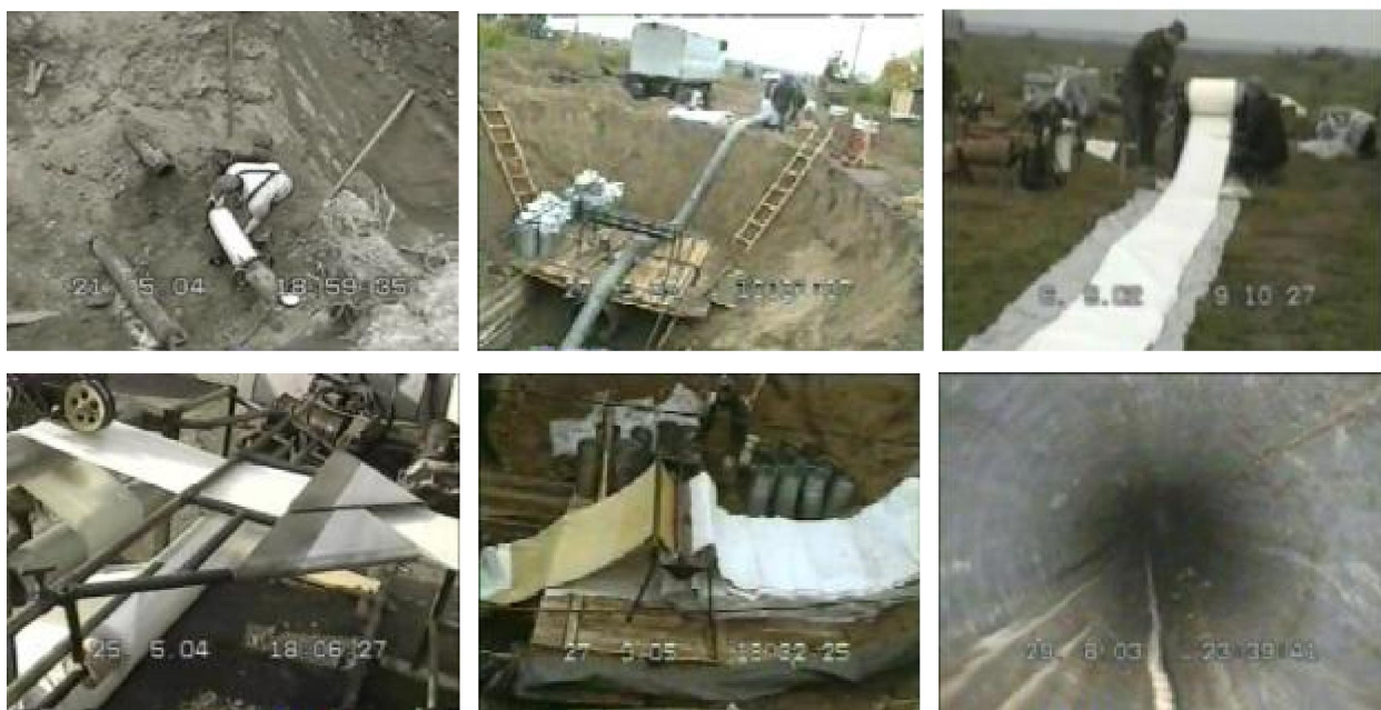
Рисунок 8 - Фрагменты восстановления трубопроводов
