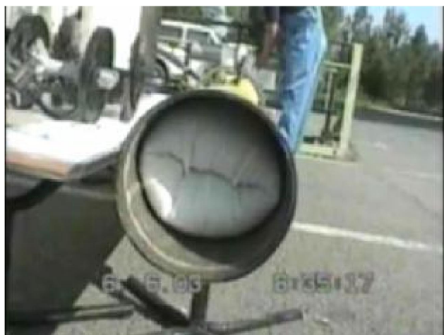
Рисунок 7 – Введение рукава в трубопровод
