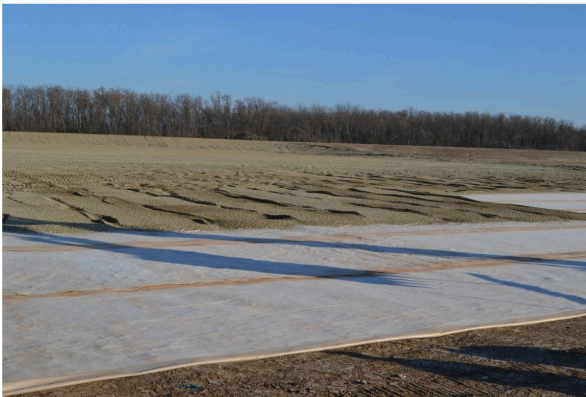
Рисунок 6 – Противофльтрационный экран с бентоматами и защитным слоем из щебня
