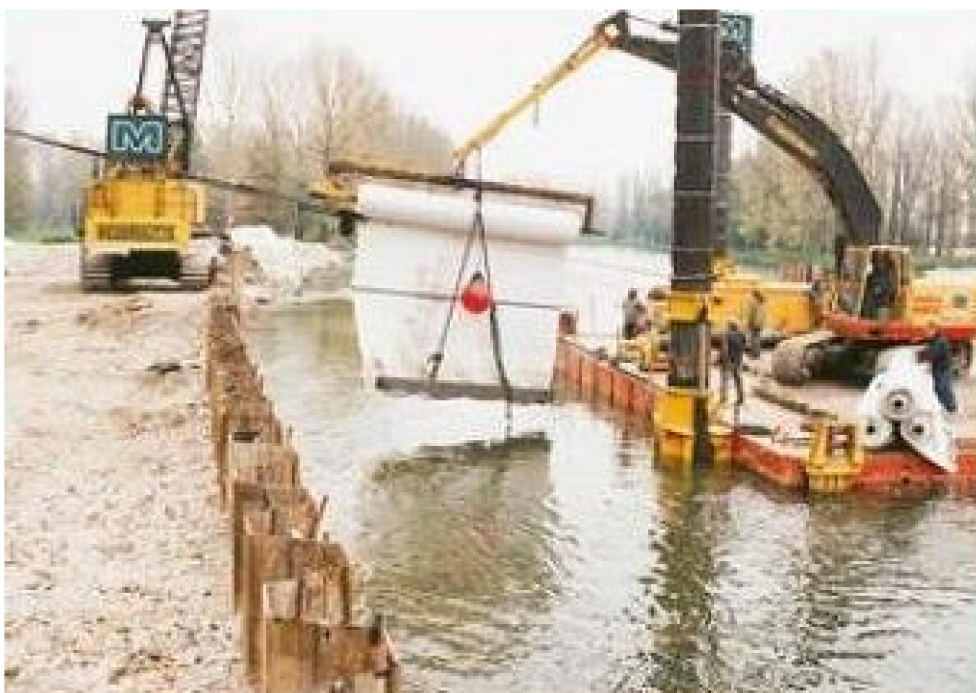
Рисунок 1 – Укладка бентоматов в канал Дортмунд-Эмс
