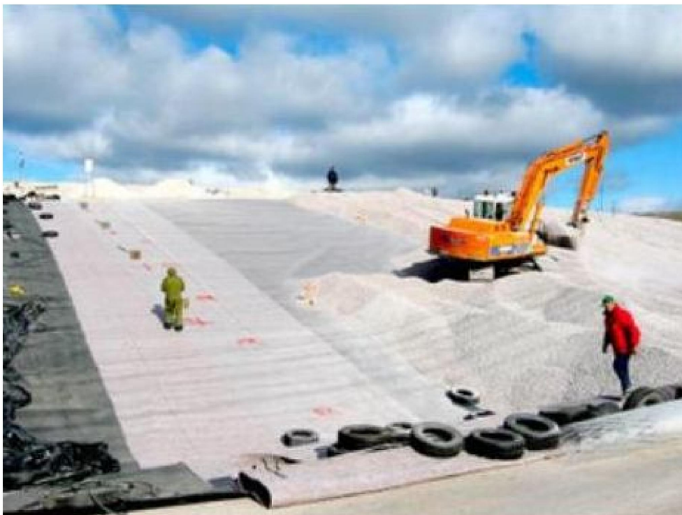
Рисунок 4 – Реконструкция накопителя отходов с применением геосинтетических материалов
