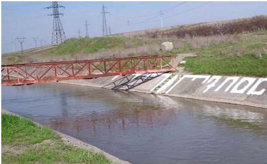
Рис.1. Гидрометрический пост типа «ФР» оборудованный гидрометрическим мостиком
