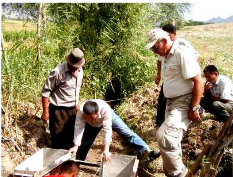
Рис.6. Установка металлической опалубки для отливки лотка САНИИРИ
