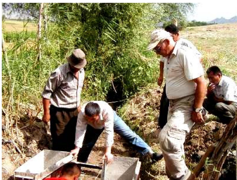
Рис.6. Установка металлической опалубки для отливки лотка САНИИРИ
