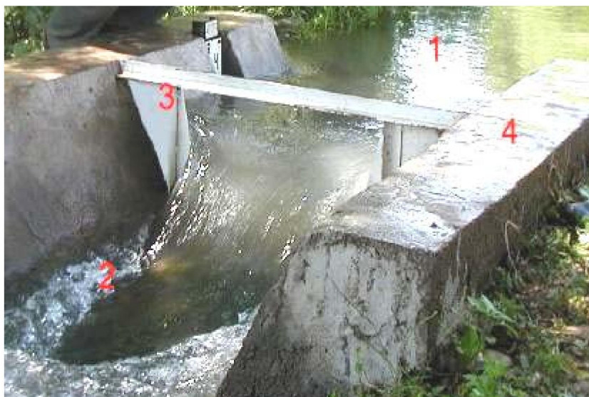
Рис.2. Водослив Чиполетти (вид с нижнего бьефа): 1- подводящий участок; 2-отводящий участок; 3-водослив; 4-крепление бермы.
