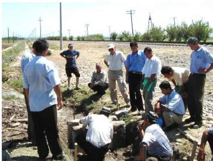
Рис. 5. Установка «ВЛС» заводского изготовления в створе гидростоя
