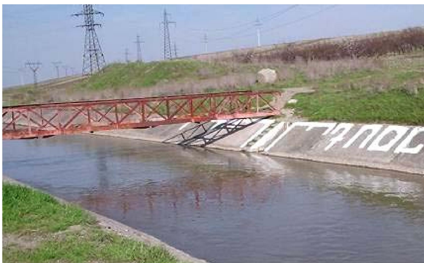
Рис.1. Гидрометрический пост типа «ФР» оборудованный гидрометрическим мостиком
