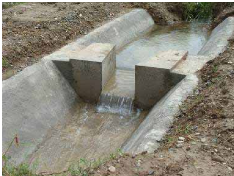
Рис. 6. Гидропост с ВЛС, вид с нижнего бьефа
