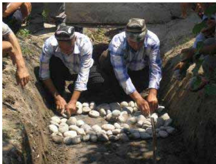
Рис.12. Укладка каменной наброски под основание водомерного устройства.
