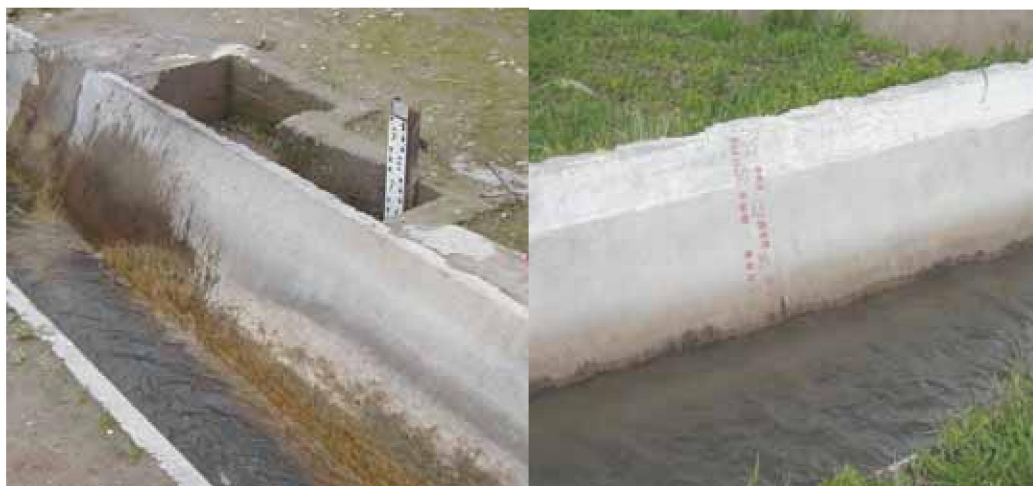
Рис.9. Градуированный параболический лоток: а) с успокоительным колодцем б) с расходомерной шкалой
