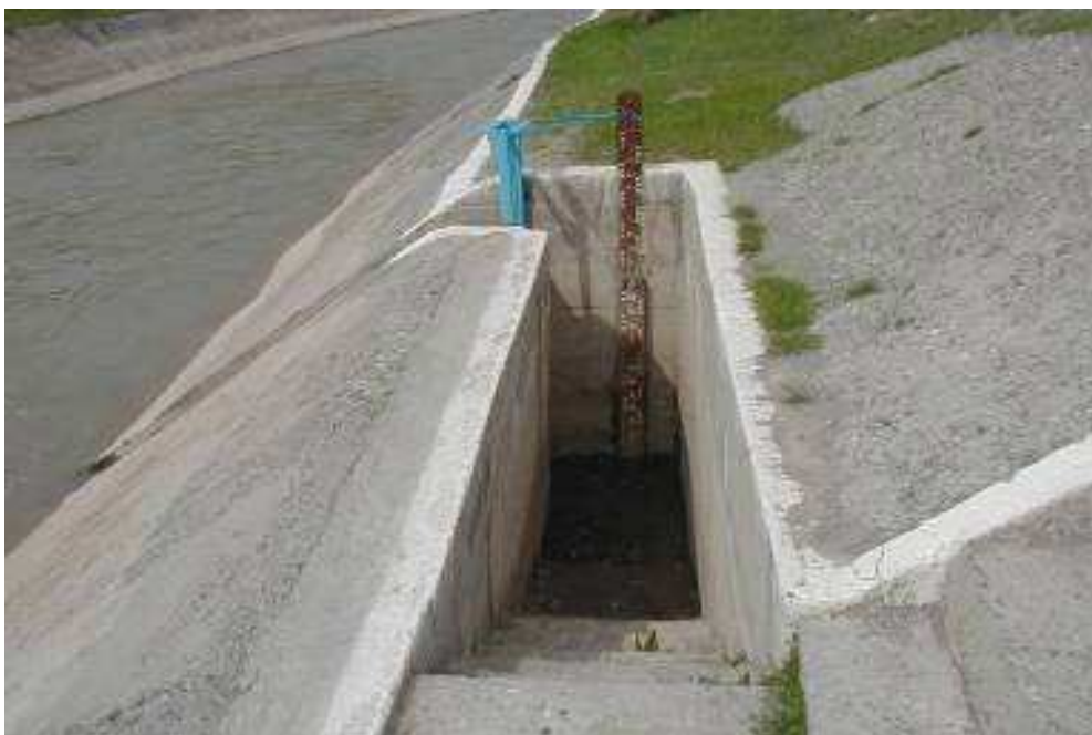
Рис. 3. Успокоительный колодец с гидротехнической рейкой
