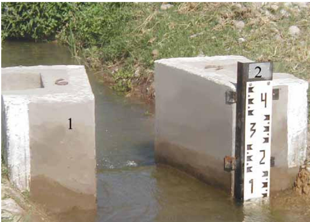
Рис. 3. Водомерный лоток САНИИРИ, подводящая часть 1 – входные открьлки, 2- гидротехническая рейка
