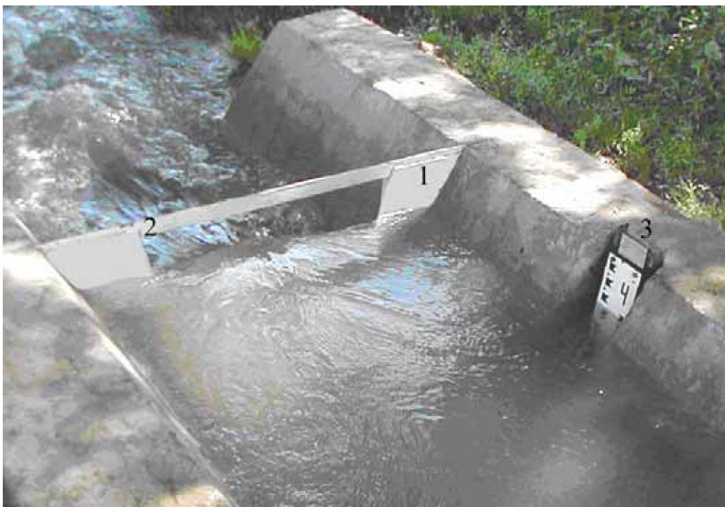
Рис. 1. Водослив Чиполетти, АВП «Жапалак» Кыргызстан 1 - ВЧ-50, 2 - ребро жесткости, 3 – успокоительная ниша с гидротехнической рейкой
