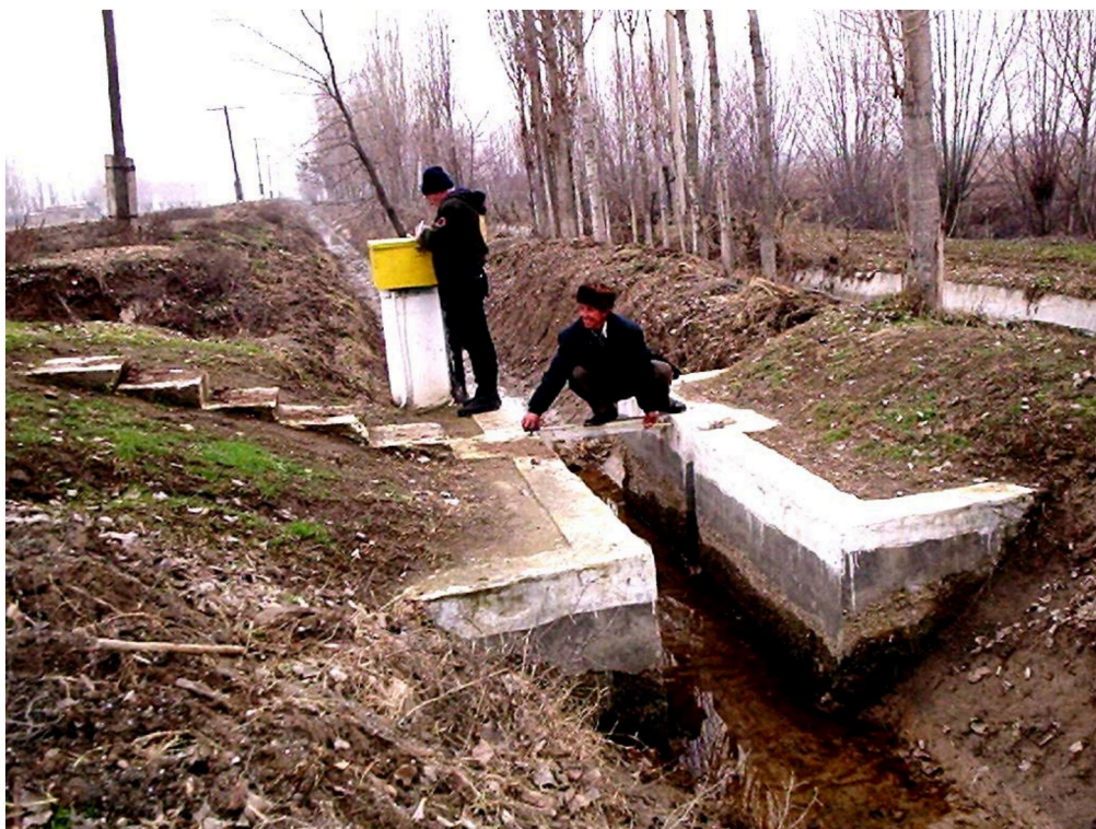
Рис. 7. Гидрометрический пост типа «фиксированное русло».
