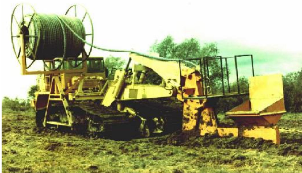
Рисунок 1 - Укладка дрены с фильтром из нетканого материала
