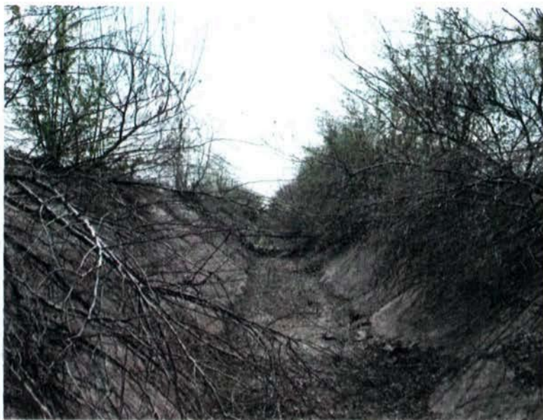
Рис. 1.14. Оросительный канал, заросший древесно-кустарниковой растительностью
