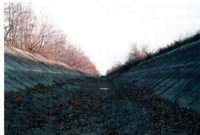
Рис. 1.15. Заиленный участок оросительного канала
