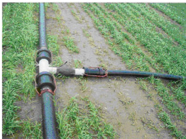
Рис.2. Установка тройника на распределительном трубопроводе
