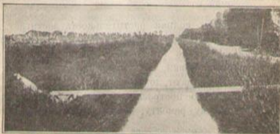
Фотогр. III. Тот же канал (фот. II) при сильном развитии растительности ( n = 0,029 ).
