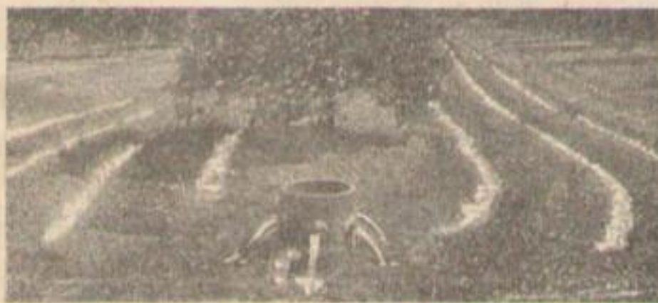
Фот. XV. Орошение трубами с распределением воды по бороздам. Farmer's Bulletin, № 899.
