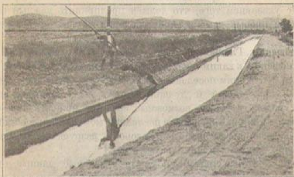
Фот. IV. Удаление моха на бетонированных каналах.
