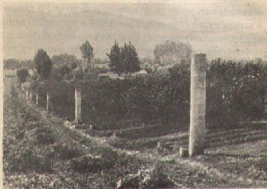
Фот. V. Орошение трубами. Линия распределительных гидрантов и регулирующих стояков; из гидрантов через отверстие в них вода поступает в борозды, видимые с правой стороны от линии трубопроводов. Farmer's Bulletin, № 906.
