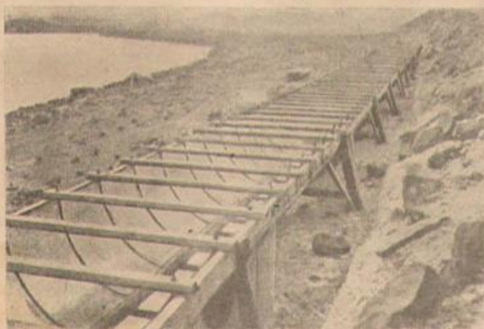
Фотогр. V. Лоток (металлический) диаметром в 2,13 метра (1саж.). (С. Ш. С. Америки, шт. Айдахо, Система Моунтеи Хом.).
