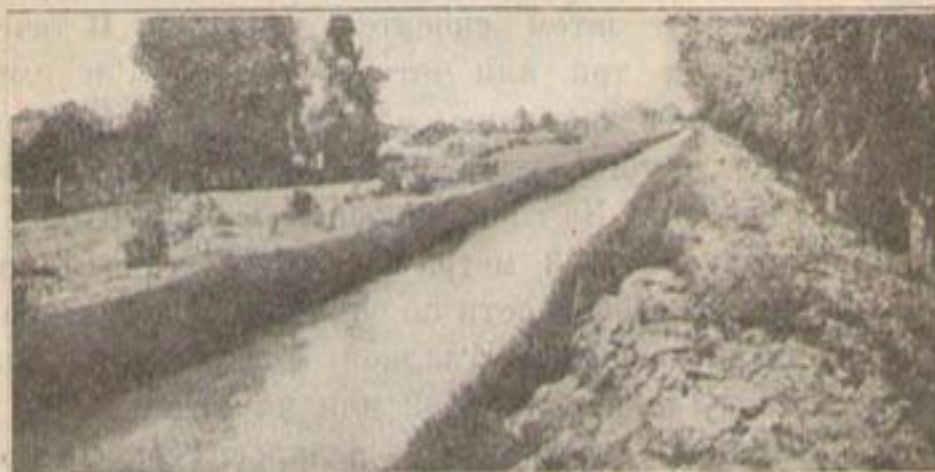
Фотогр. II. Канал вскоре после очистки от растительности ( n = 0,022 ).
