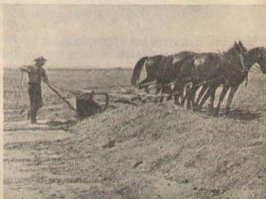
Фот. VI. Постройка валиков скреперами Фресно. В. А. Etcheverry.
