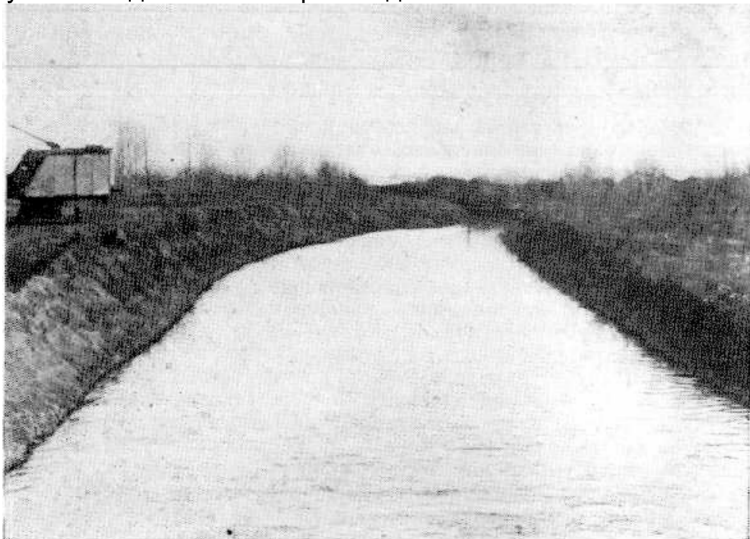
Рис. 80. Инфильтрационный канал на водозаборе из р. Томь
