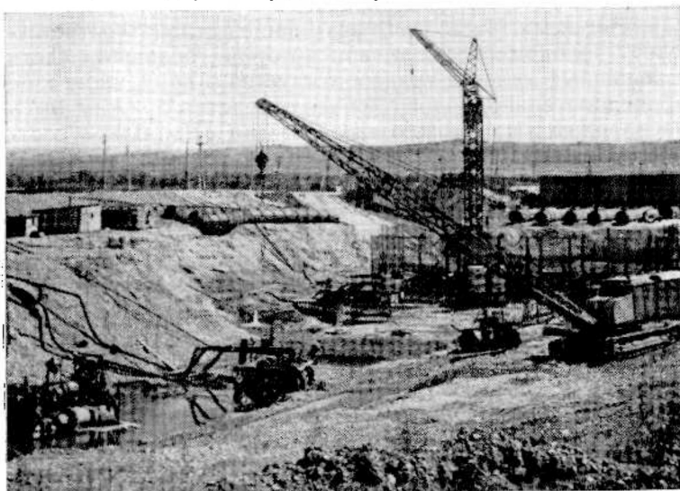
Рис. 6. Строительство ковшового водозабора на р. Томь
