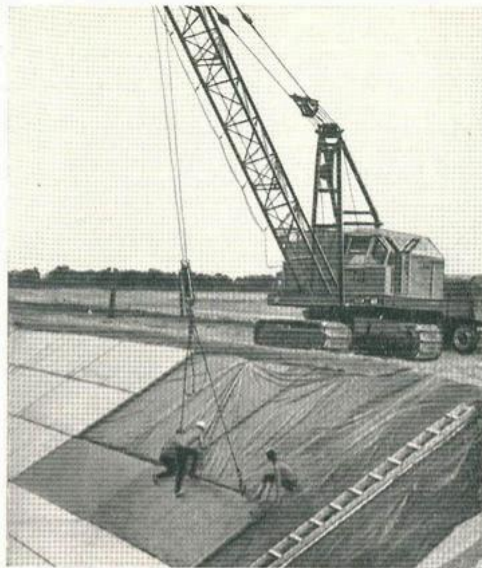
Рис. 73. Устройство комбинированной бетонопленочной облицовки на распределительном канале Р-2 Каховской оросительной системы.
