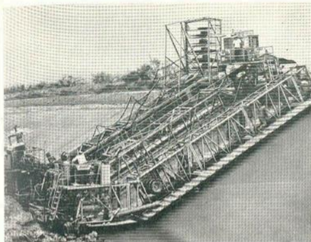
Рис. 71. Устройство бетонной облицовки на распределительном канале Р-5 Каховской оросительной системы бетоноукладочным комплексом «Рахко».
