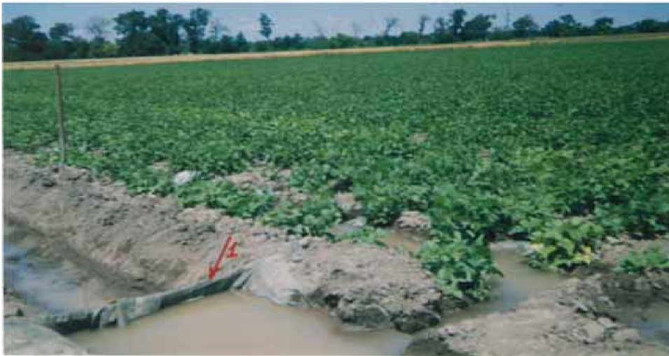
Фото 7. Гибкий перегораживающий подпорный щит – регулятор расхода воды
