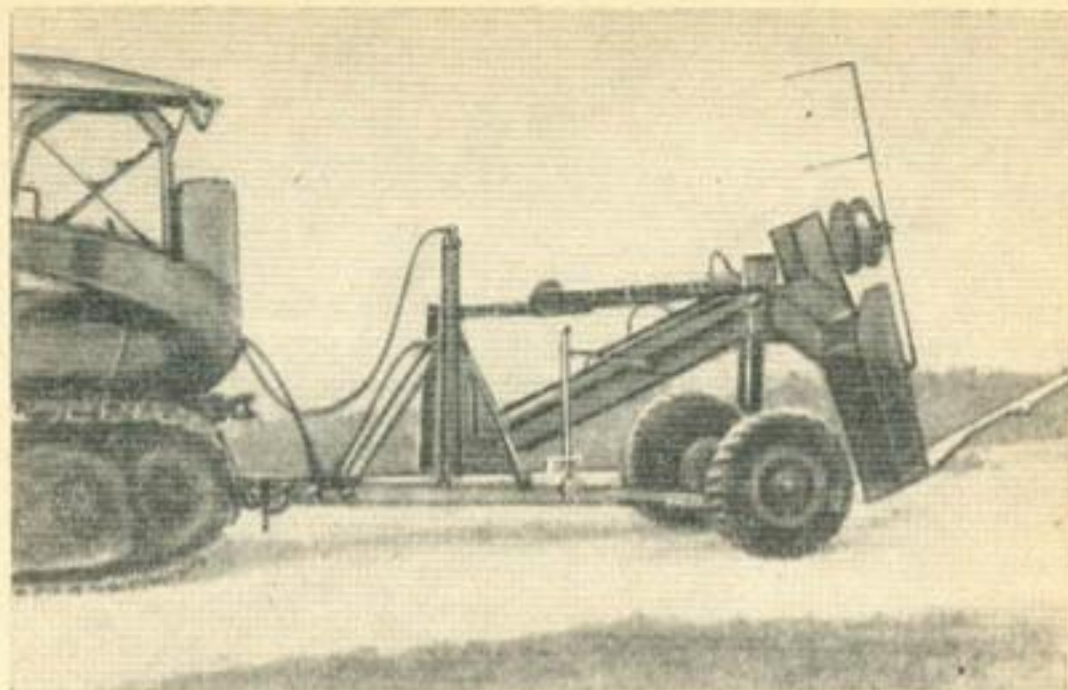
Рис. 8. Веймарский плуг, подготовленный для передвижения своим ходом.
