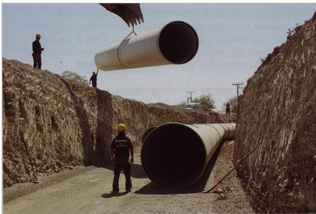
Рисунок 2 – Монтаж трубопровода из стеклопластиковых труб
