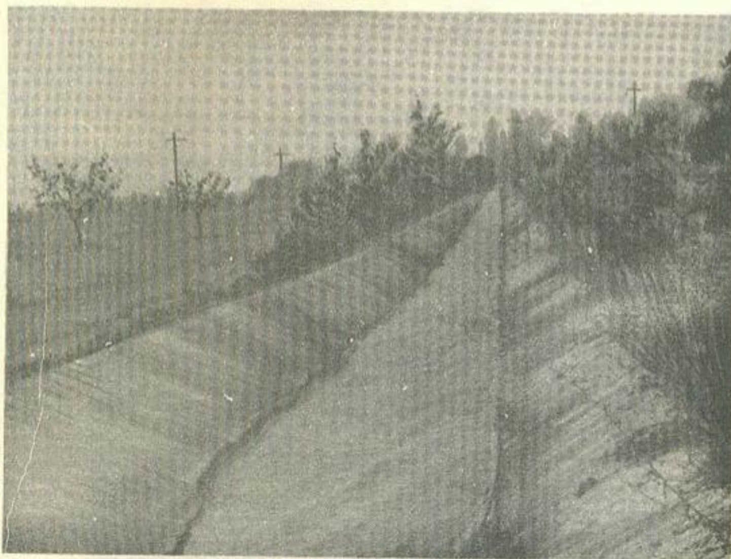
Рис.29. Канал МАК. Монолитная облицовка
