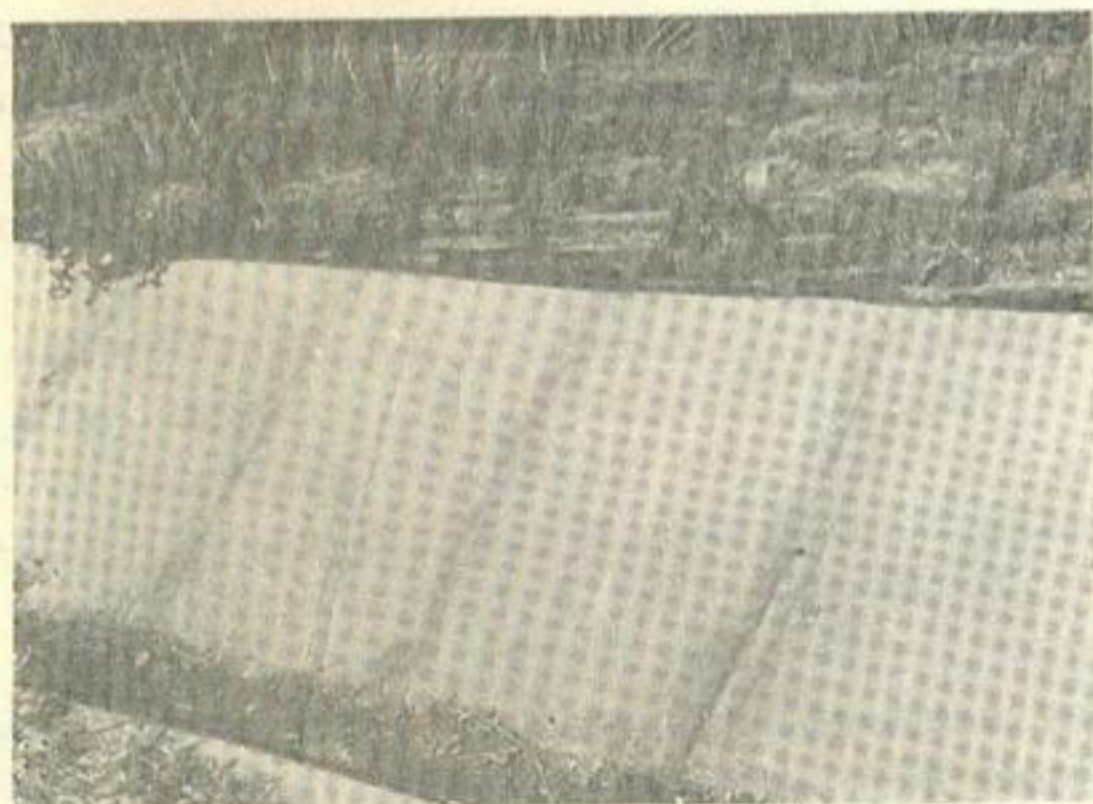
Рис. 36. Канал 1-х-8-3. Вид облицовки из плит
