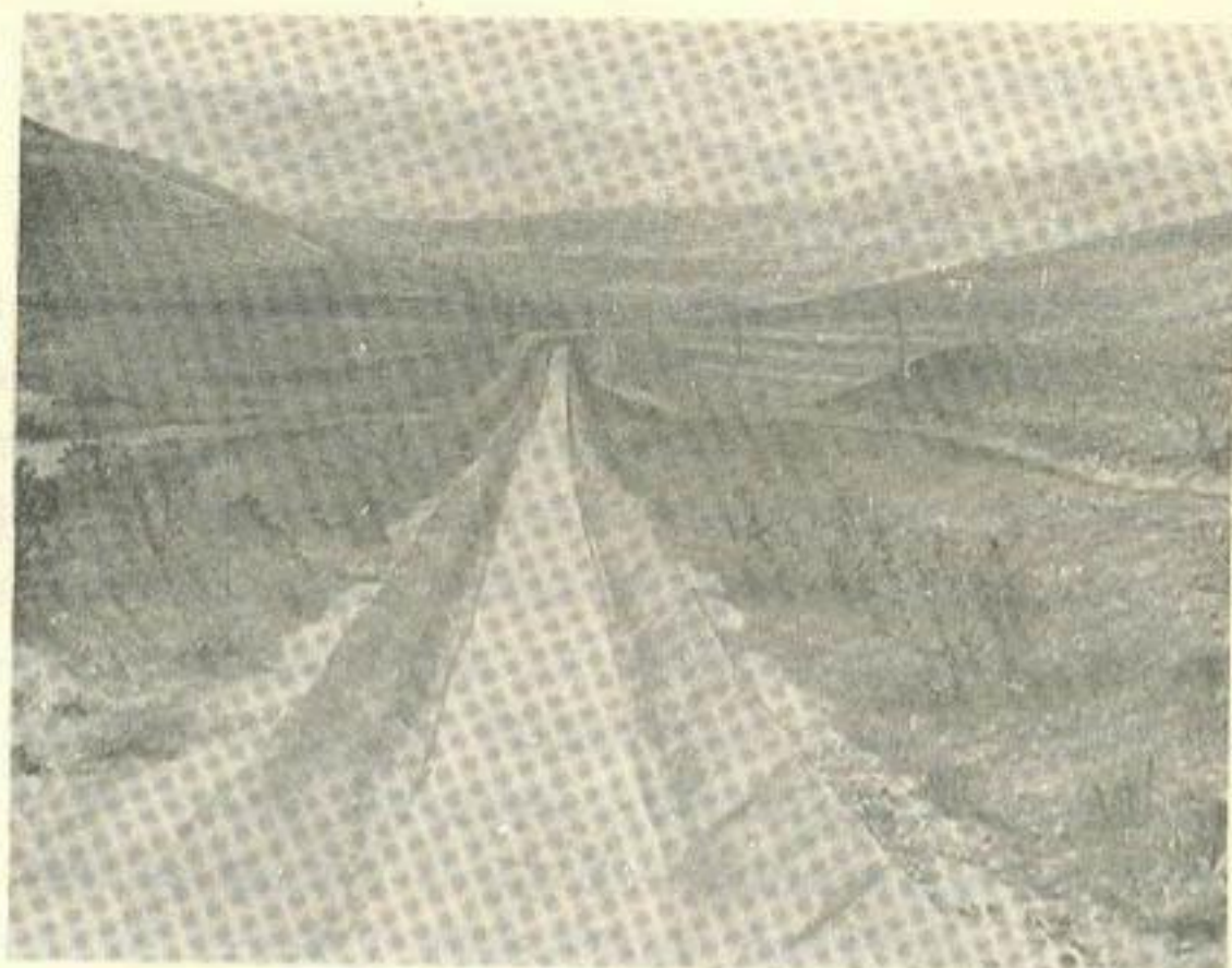
Рис.27. Облицовка канала Шахмедарх.
