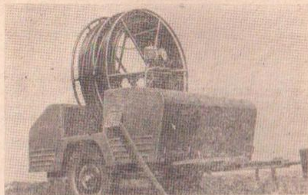
Р и с. 30. Дренопромывочная машина Д-910
