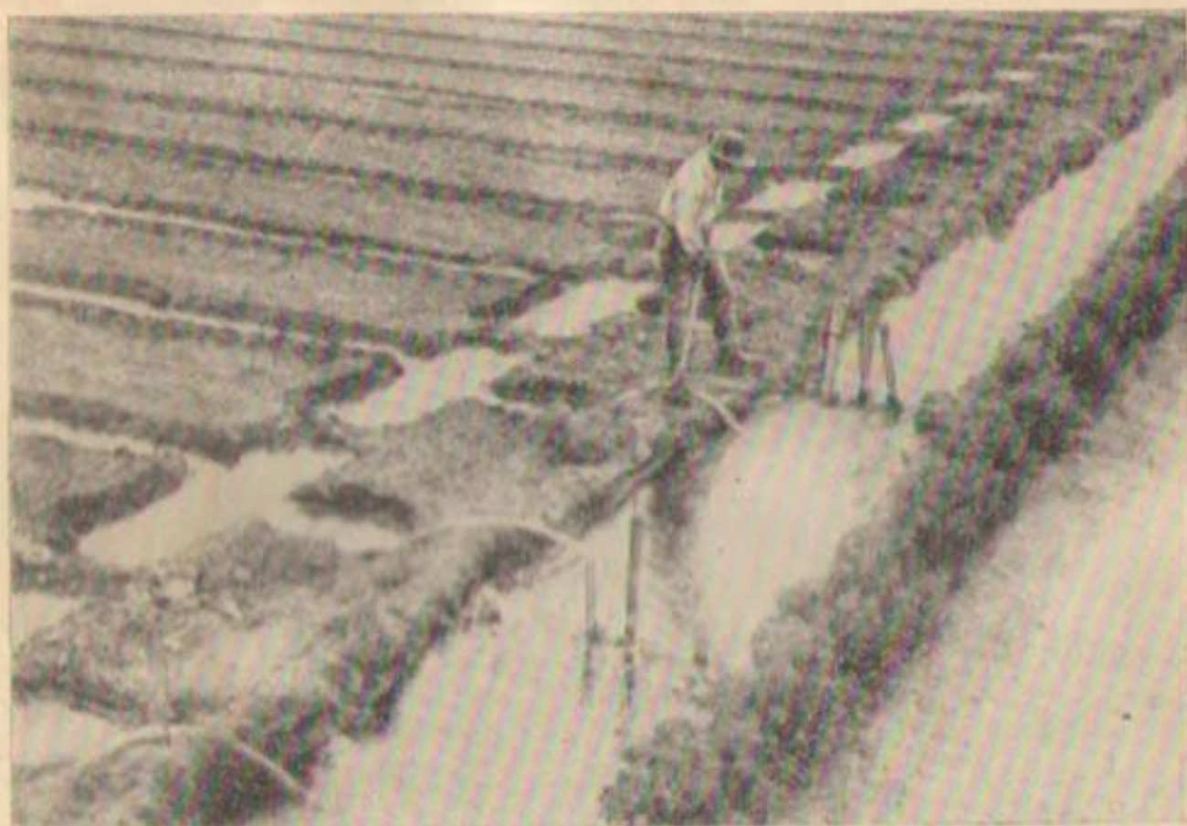
Р и с. 77. Сифонные трубки, изготовленные из пластмассы и применяемые для полива по бороздам.
