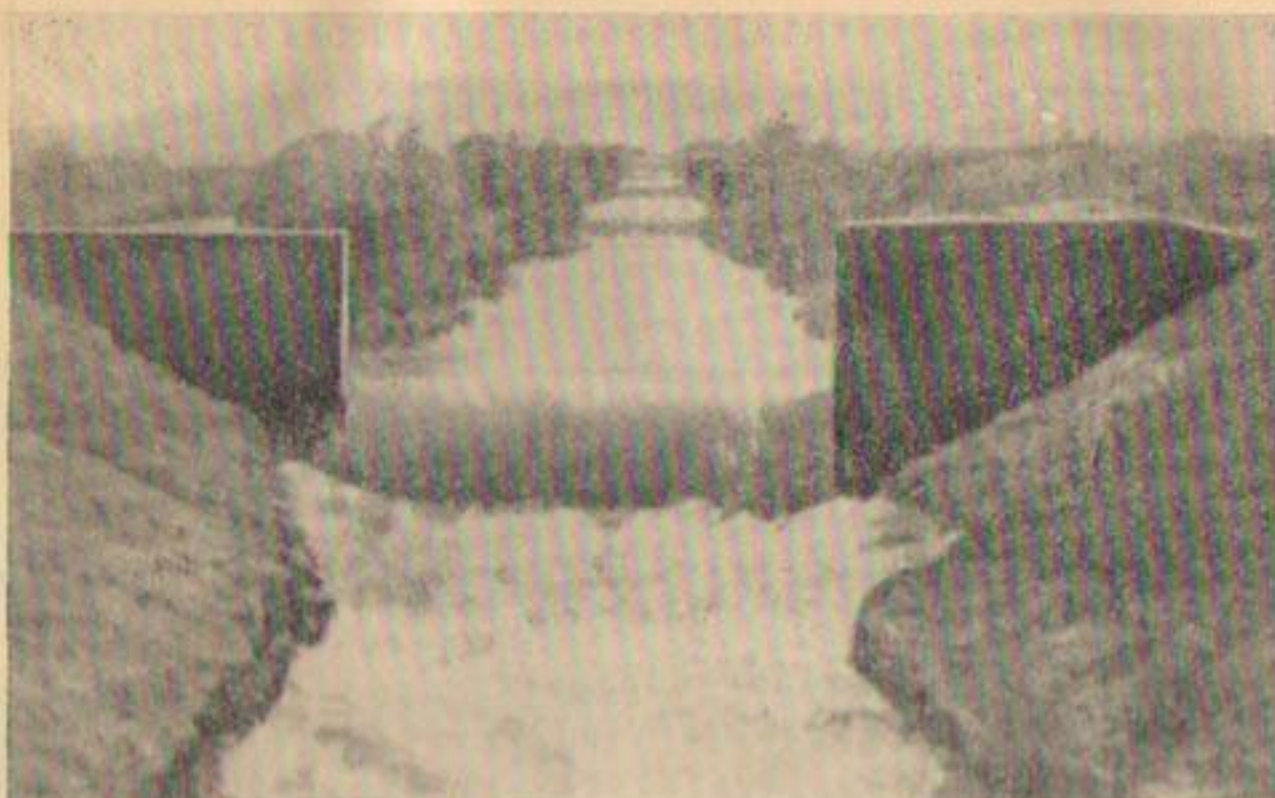
Р и с. 45. Ряд последовательно расположенных перепадов для уменьшения скорости течения и предупреждения размыва. Для поднятия уровня воды в канале могут быть установлены узкие щиты, скользящие в пазах. Благодаря этому можно производить полив полей по обеим сторонам канала.
