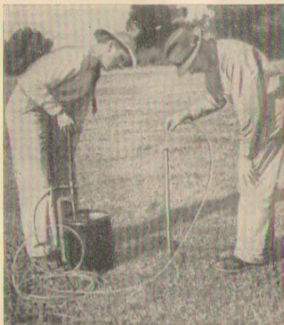
Р и с. 130. Вымывание полости под трубкой пьезометра.
