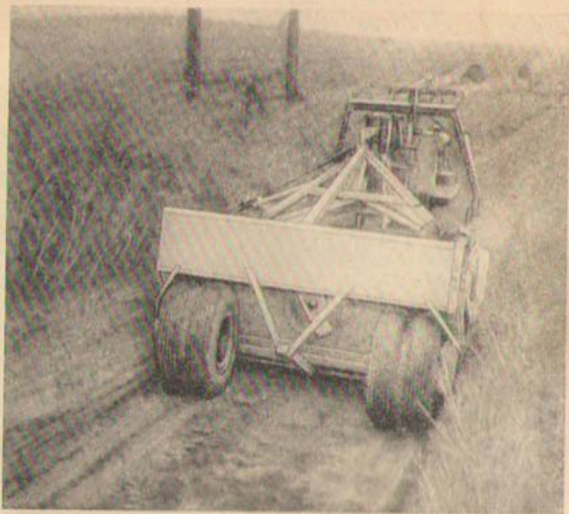
Р и с. 89. Скрепер на тяге гусеничного трактора. Применяется для рытья каналов с крутыми откосами с перемещением грунта на большие расстояния.
