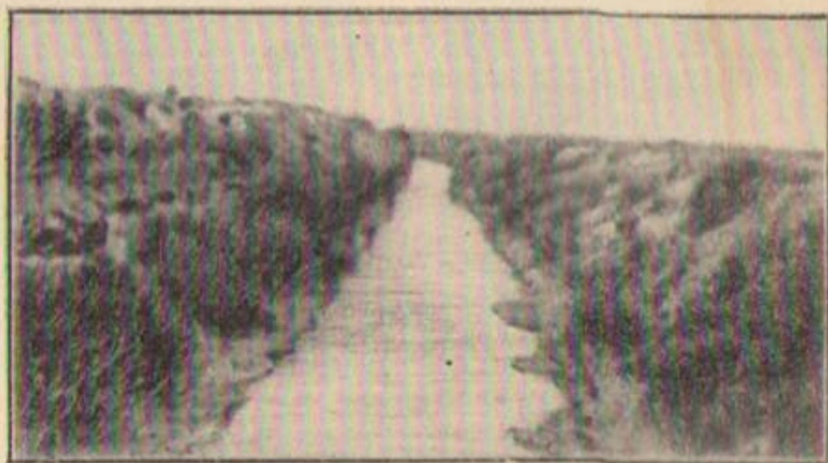
Рис. 146. Обычный открытый канал в штате Нью Мексико. Ширина канала по дну приблизительно 6 м; пропускная способность его 3,5 м 3 /сек.
