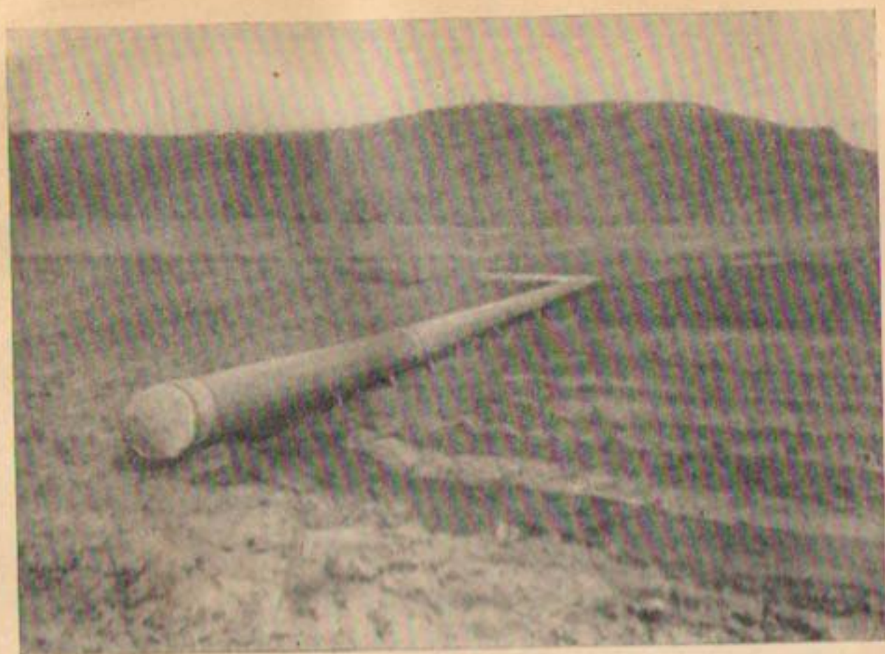
Р и с. 99. Четырнадцать борозд, в которые вода подается из трубы с задвижками.
