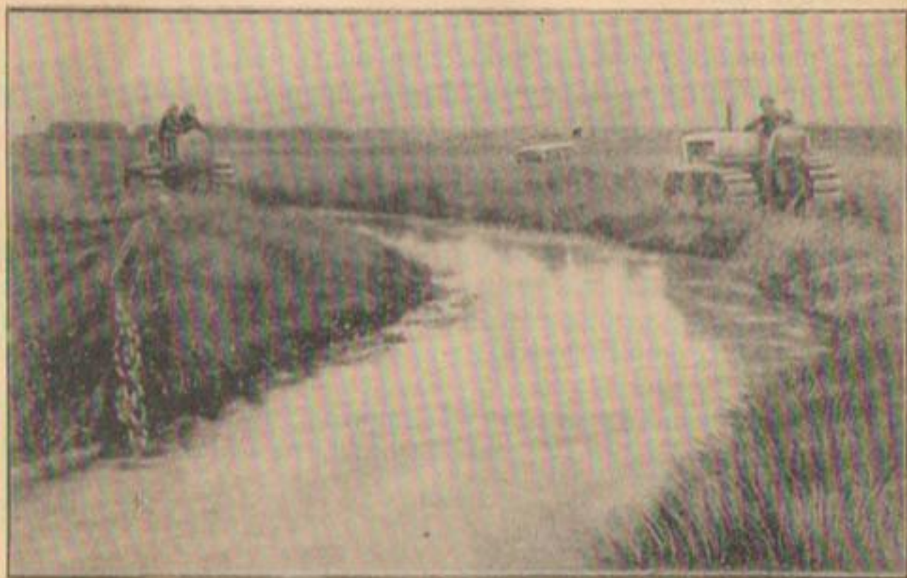
Рис. 34. Дизельные тракторы тянут большую цепь весом 1040 кг, при помощи которой дно канала очищается от мха и сорной растительности.
