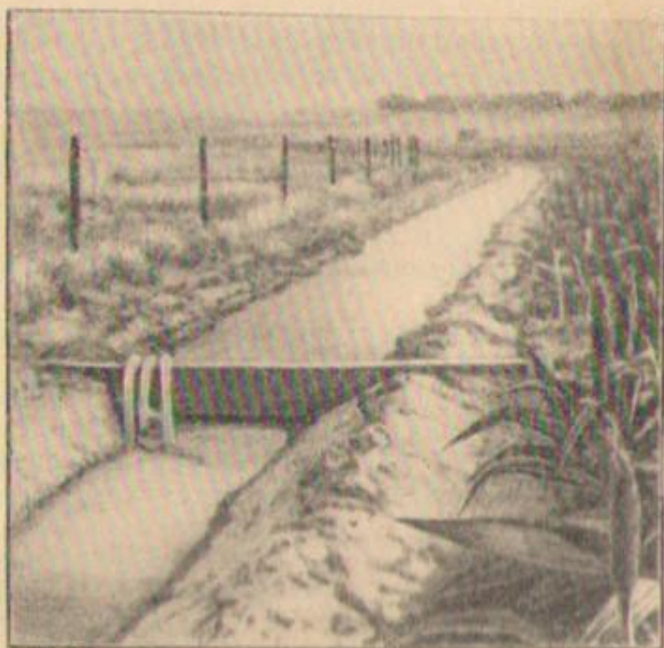
Р и с. 97. Перемычка, установленная в оросительном канале.
