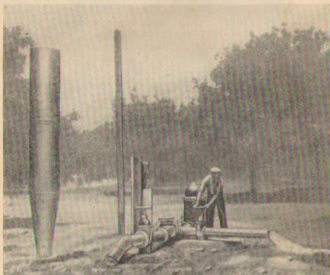
Р и с. 65. Насосная установка в саду. Глубина колодца 170 м.
