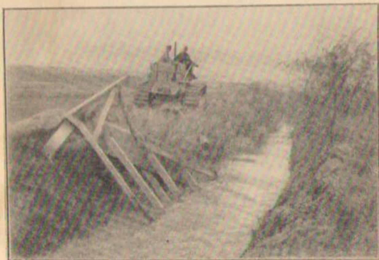
Р и с. 91. Механизм для очистки откосов каналов с длиной ножа 55 см, весом 3,2 т. Очищает канал глубиной 1,5 м с крутыми откосами.
