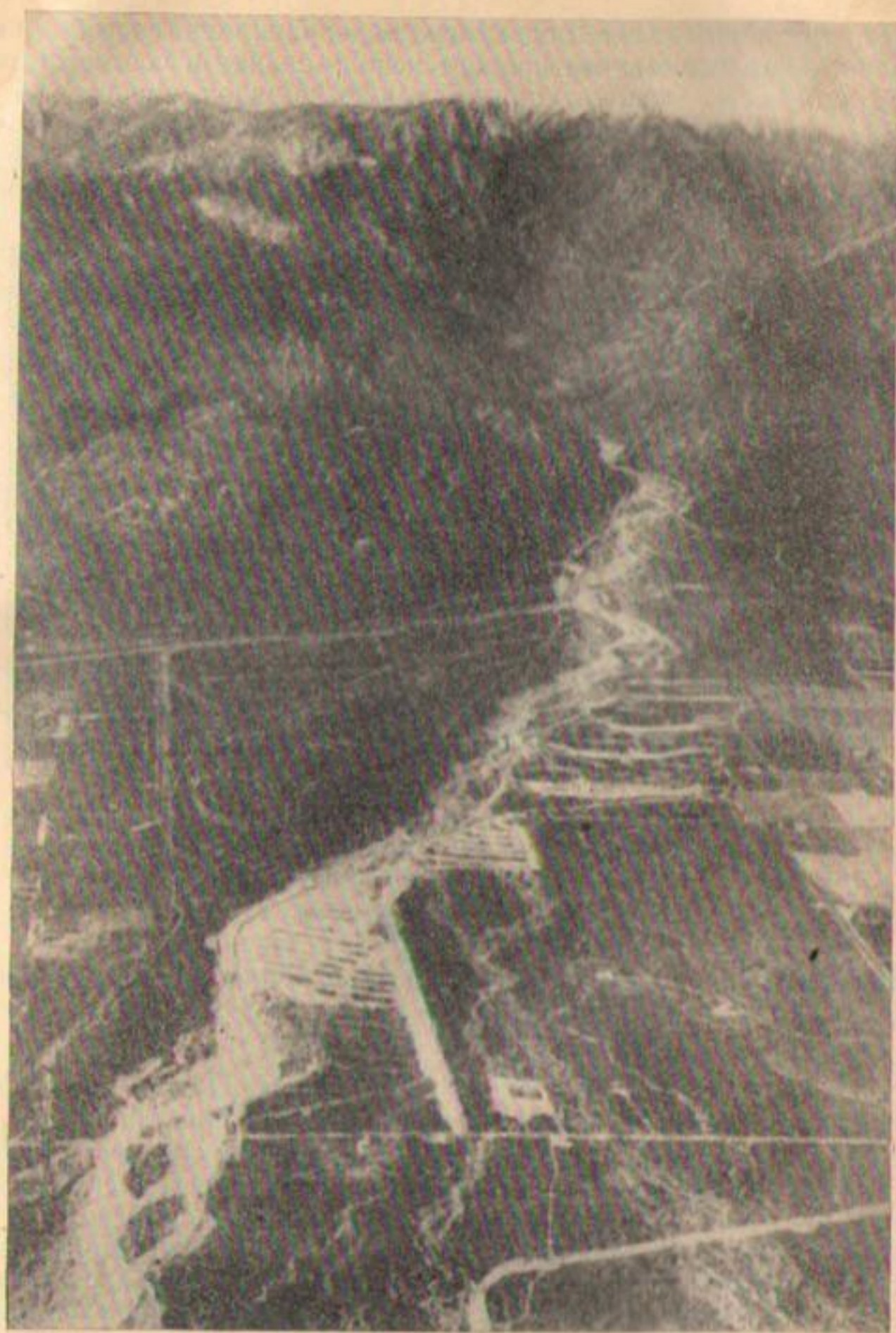
Р и с. 9. Вид с воздуха на перепады, сооруженные из обломков скал на реке Сан-Антонио. На переднем плане и вправо белые изломанные полосы обозначают направление течения; прямые параллельные полосы в направлении слева направо — перепады из обломков скал, образующие водные террасы, замедляющие течение.
