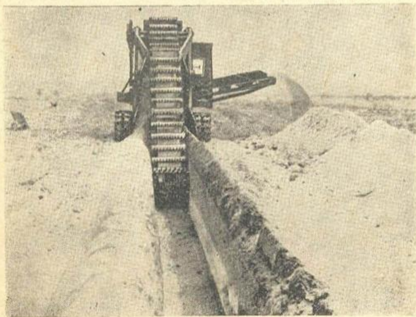
Рис. 73. Рытье траншей для трубопровода закрытой оросительной сети многоковшовым экскаватором.
