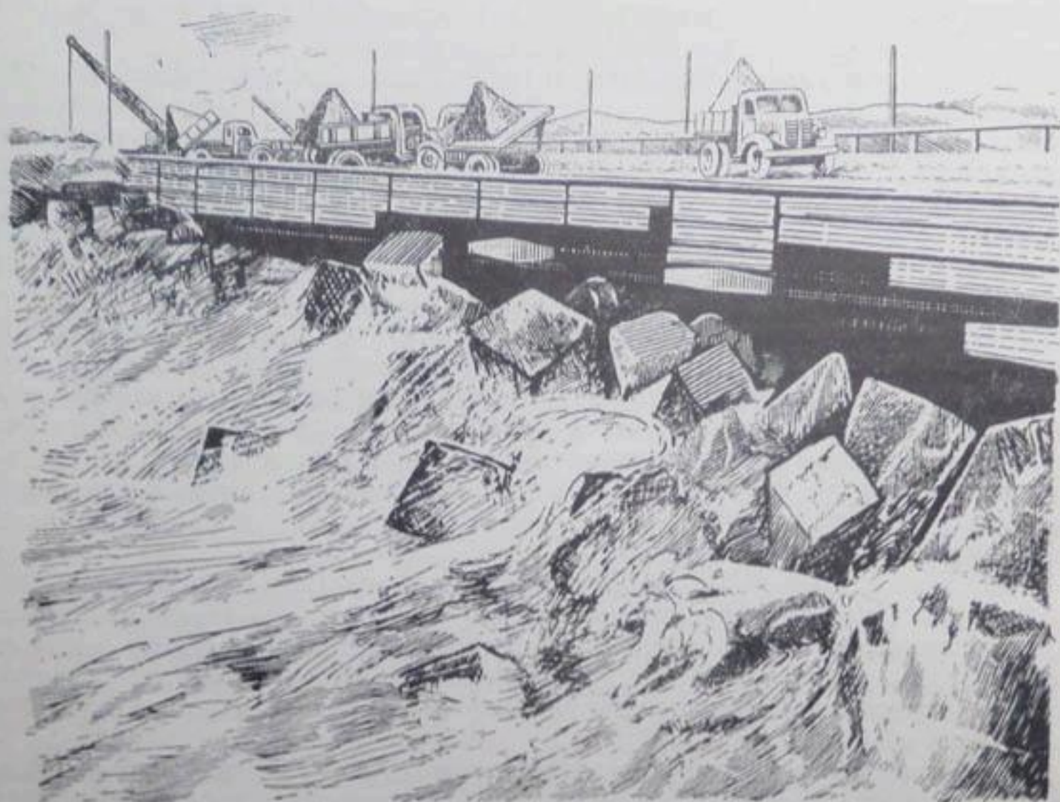
Рис. 362. Гребенка банкета из массивов, вышедшая из воды при перекрытии р. Ангара.
