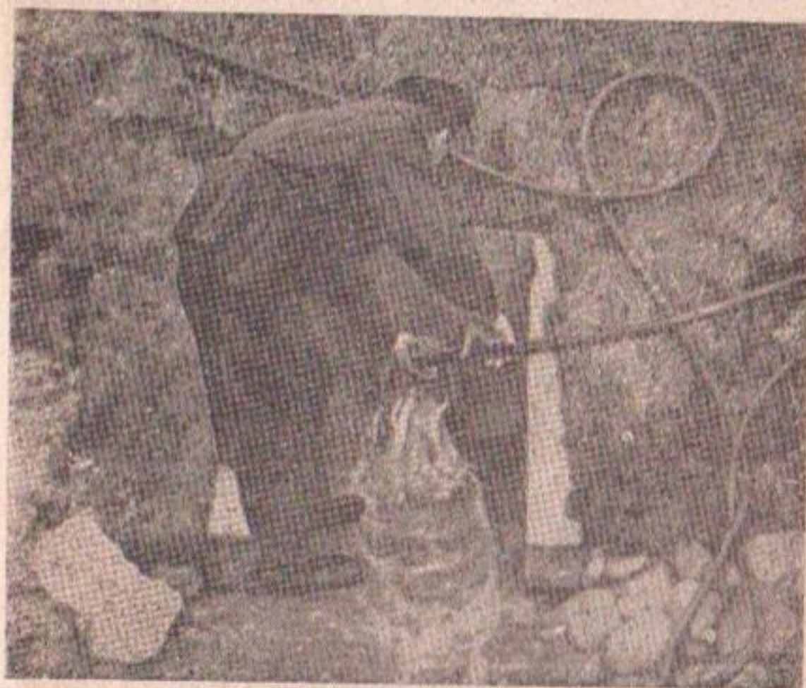
Рис. 20. Очистка дрен на опытном участке «Слоусть».
