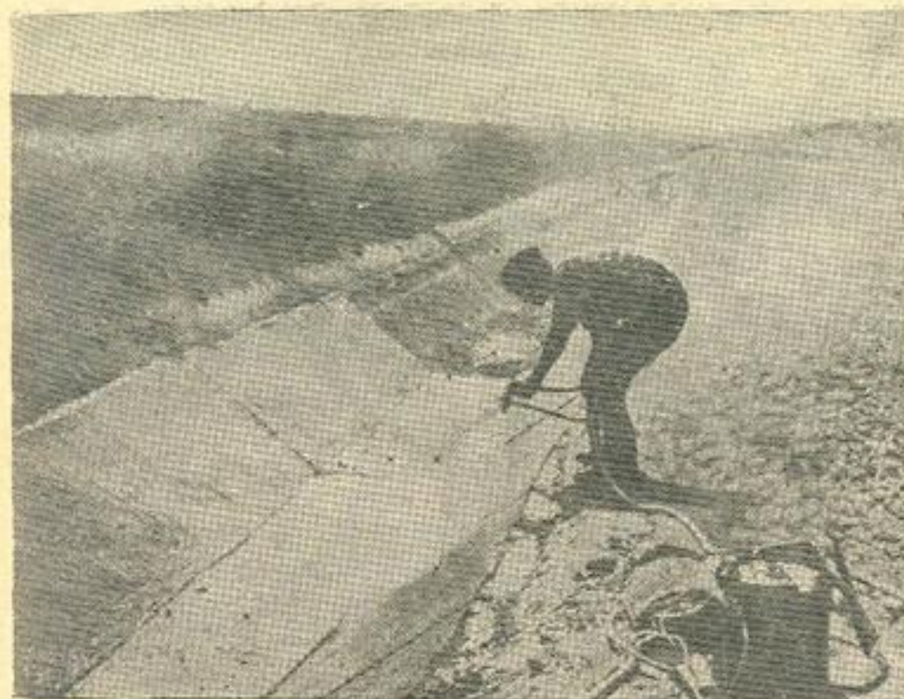
Рис. 30. Механизированное набрызгивание пленкообразующего покрытия.
