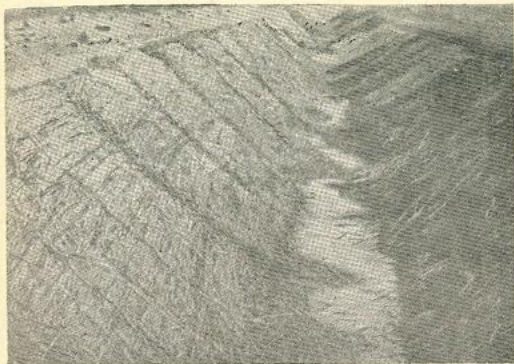
Рис. 28. Влажностный уход за бетоном с укрытием камышовыми матами.
