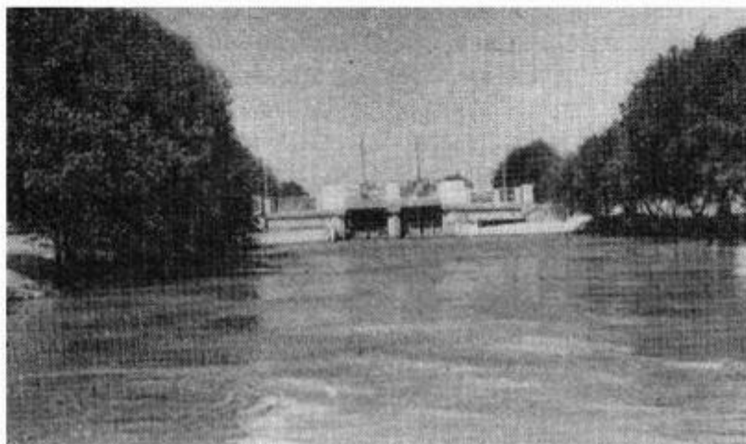
Рис. 33. Перегораживающее сооружение на ПК-923 ЮГК.
