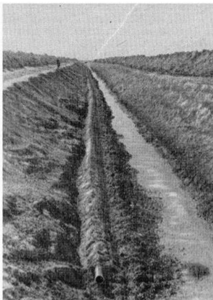
Рис. 49. Дрена, уложенная методом «полки», перед засыпкой.
