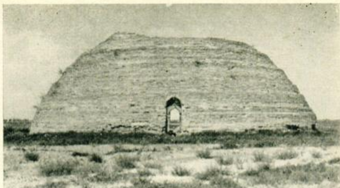
Рис. 5. «Сардоба» — защитное сооружение, возводившееся над колодцем.
