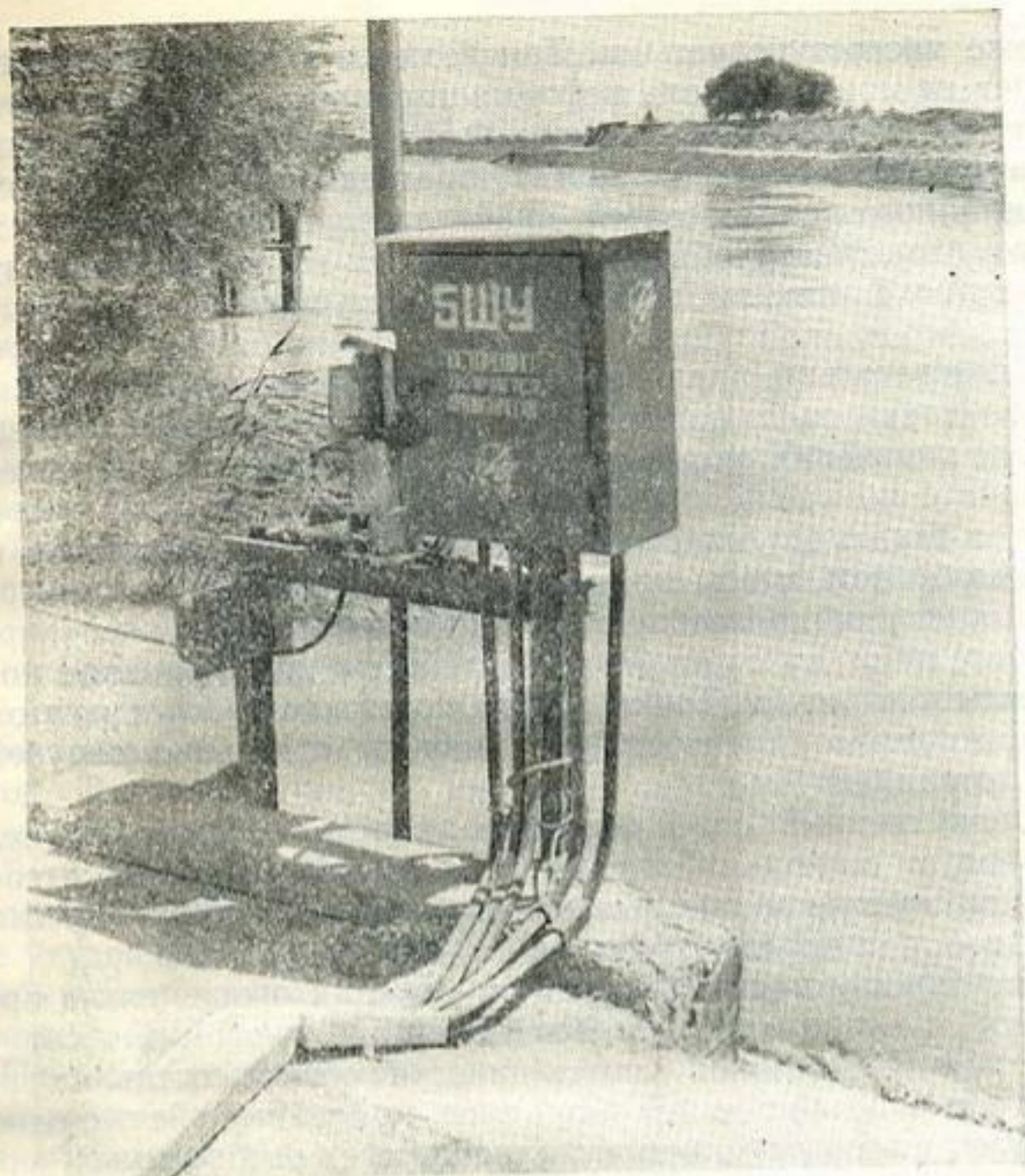
Рис. 6. Автоматизированный пульт управления на южном Голодноостенском канале.
