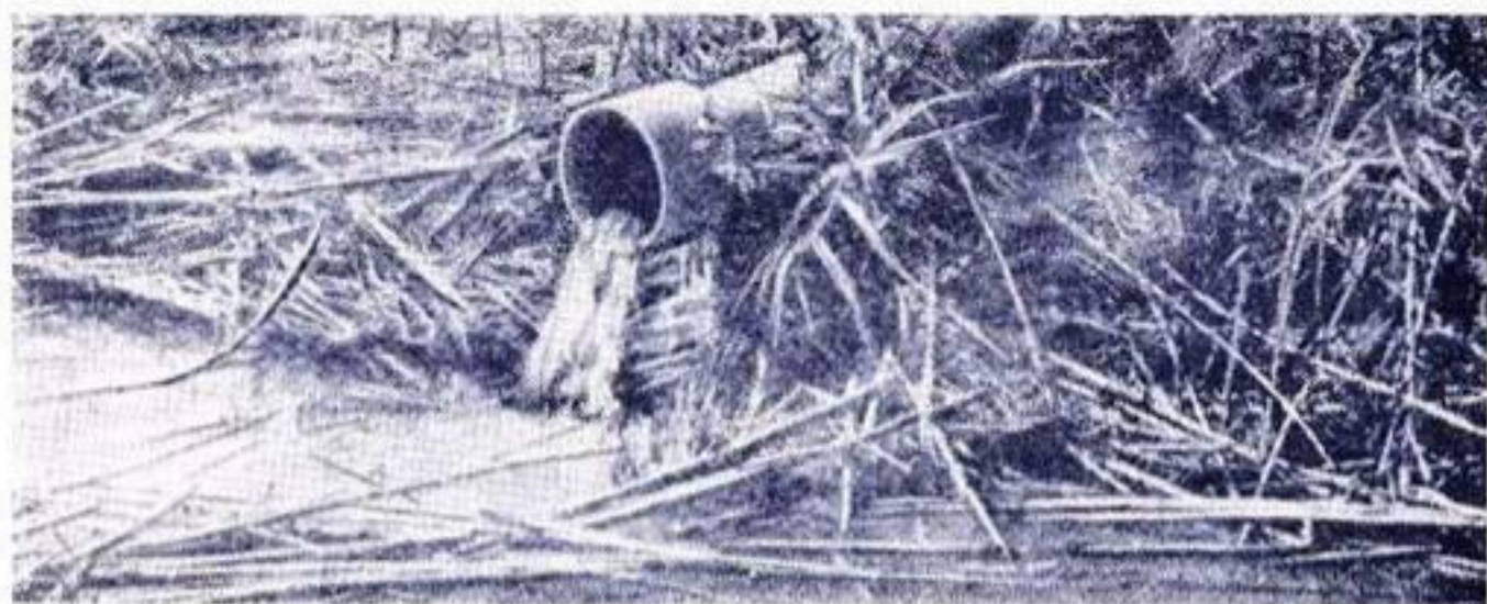
Рис. 159. Трубчатый подовыпуск в долине Импириал, штат Калифорния.
