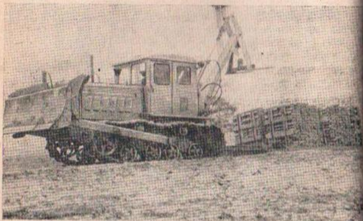
Рис. 21. Развозка труб в контейнерах по трассам.
