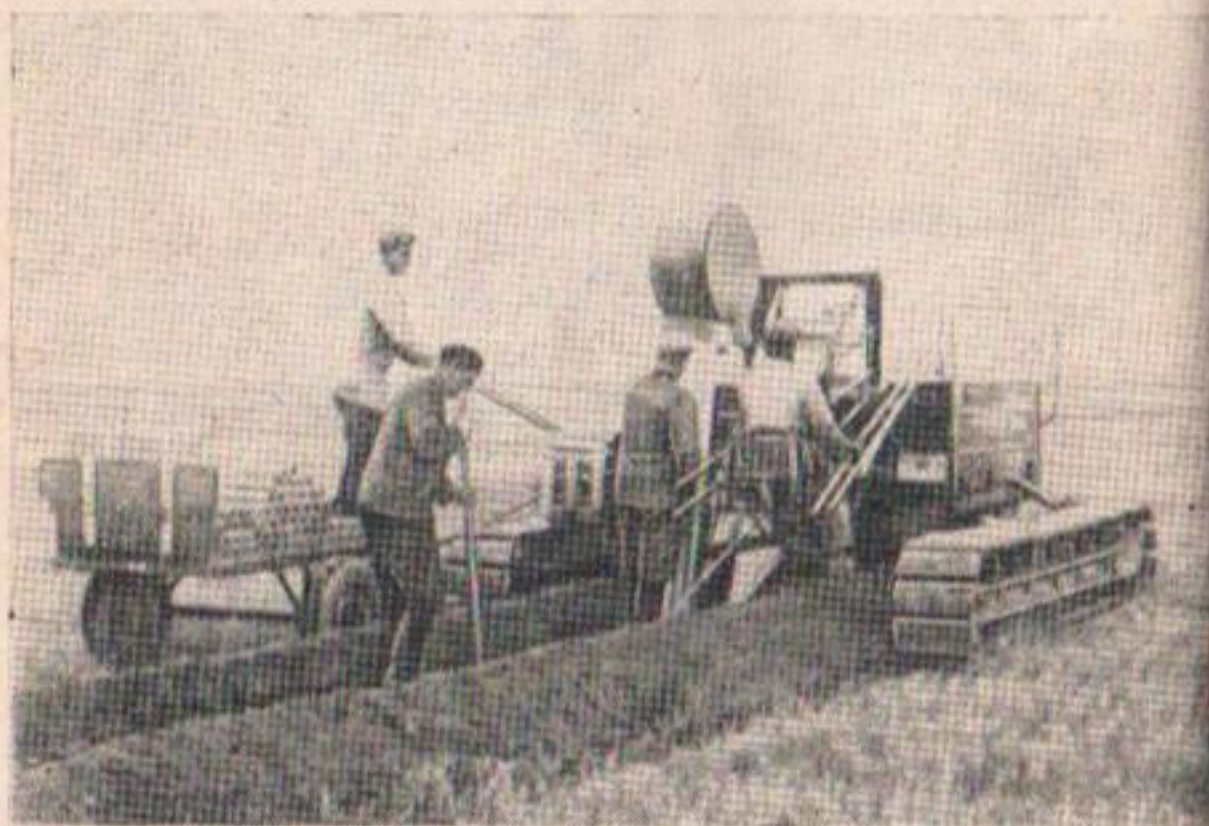
Рис. 19. Транспортировка дренажных материалов на тележке рядом с траншекопателем.
