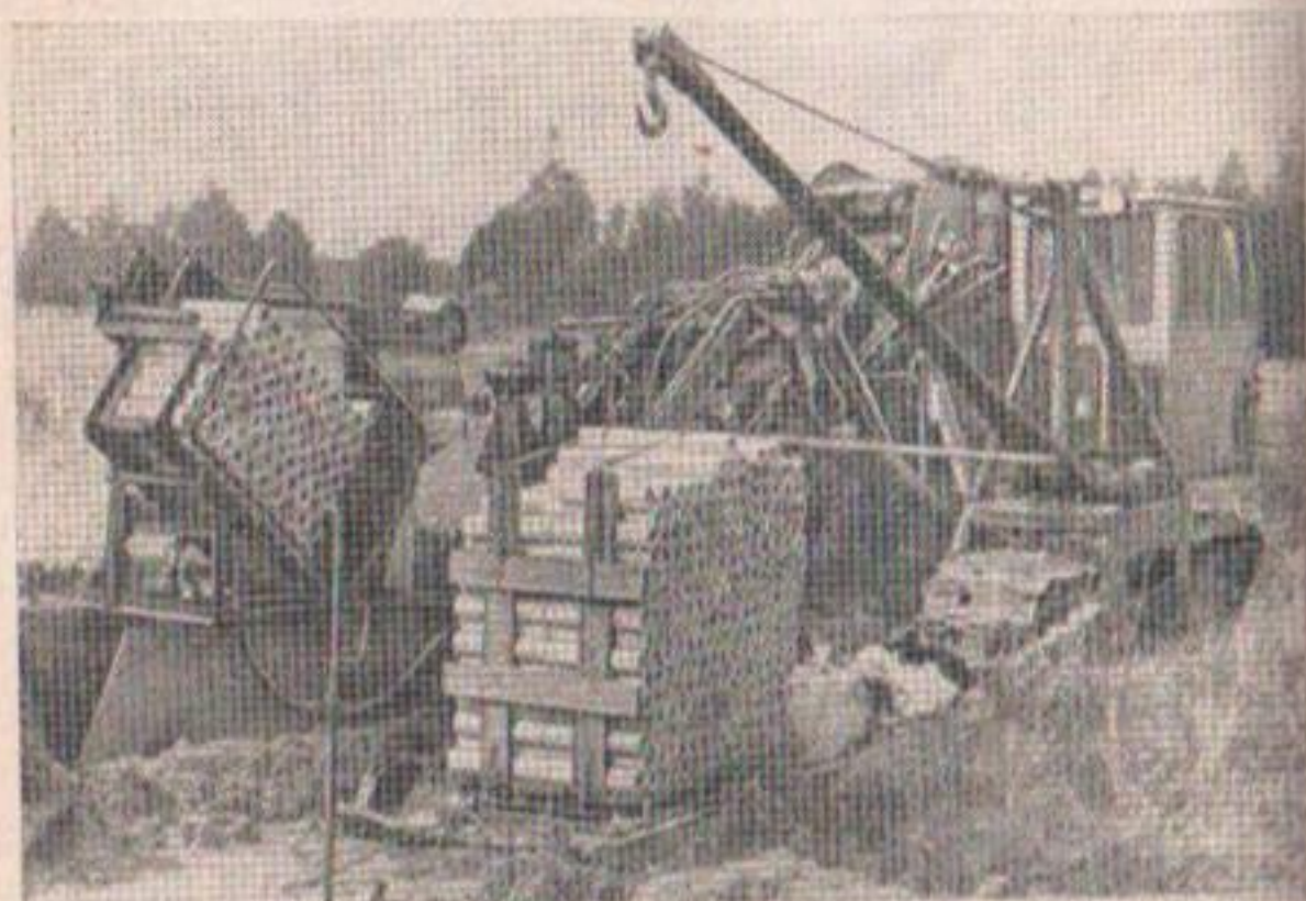
Рис. 62. Экскаватор ЭТН-171 с трубоукладчиком и с подъемно-транспортным устройством для работы с контейнерами.
