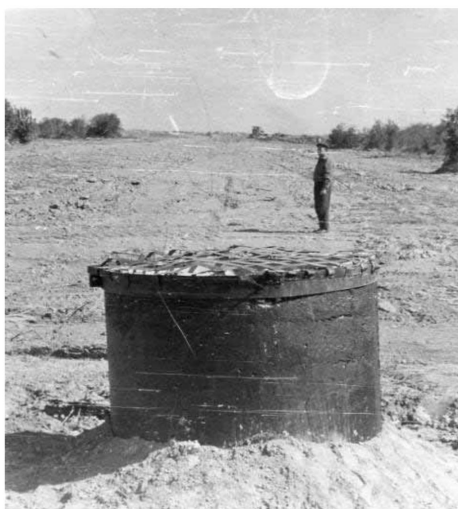
Рис. 1.5с. Устройство дренажных колодцев из сборных железобетонных колец диаметром 0,8-1,0 м
