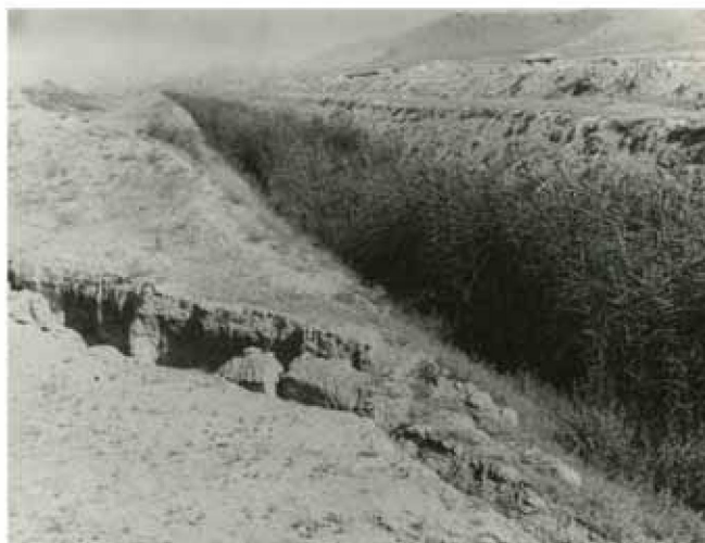
Рис. 2.4. Ирригационные эрозии приустьевой части дрен
