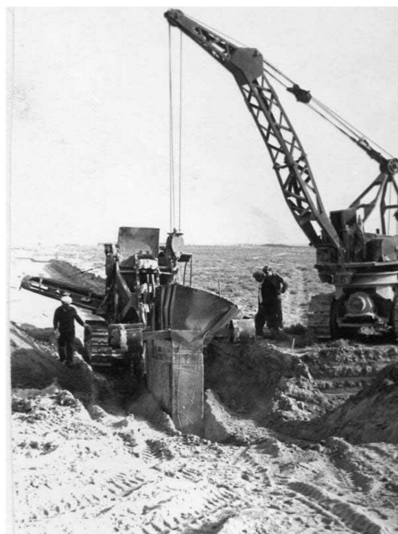
Рис. 1.18. Перемещение дренажного устройства с демонтажем бункера
