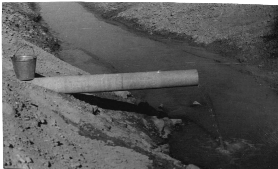
Рис. 1.7. Устье дрены в виде «консоли»
