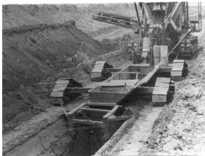
Рис. 1.24. Дреноукладчик с бункером на гусеничном ходу
