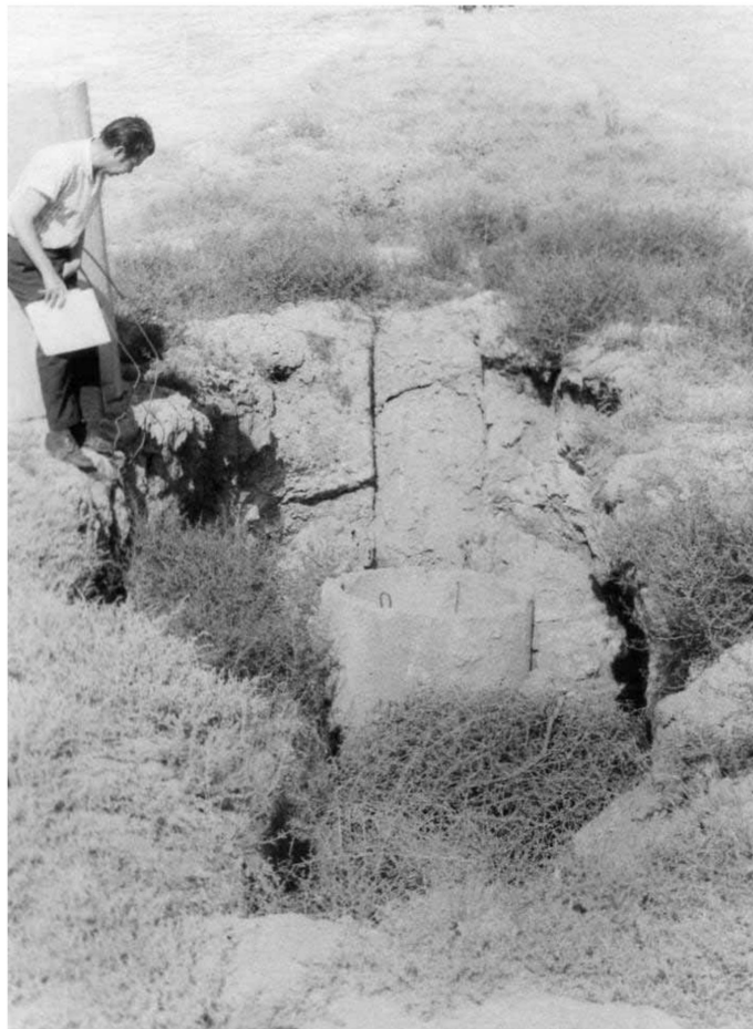
Рис. 2.3. Ирригационная эрозия вокруг дренажных колодцев
