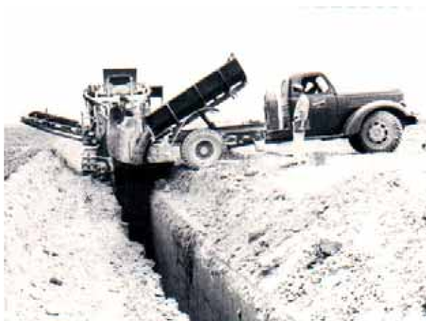
Рис. 1.19. Доставка с приобъектного склада и загрузка бункера дренаукладчика материалом фильтра с помощью автосамосвала
