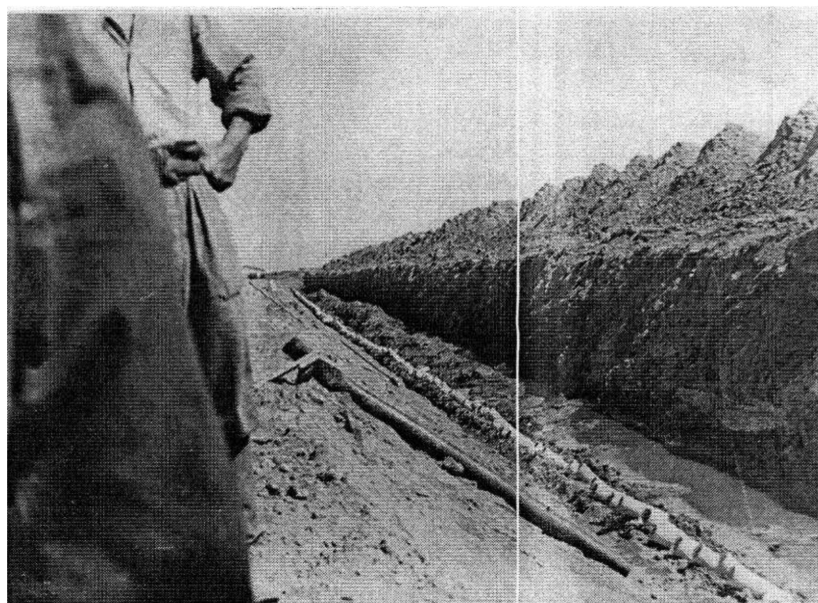
Рис. 3.13. Раскладка дренажных фасочных труб по трассе дрены
