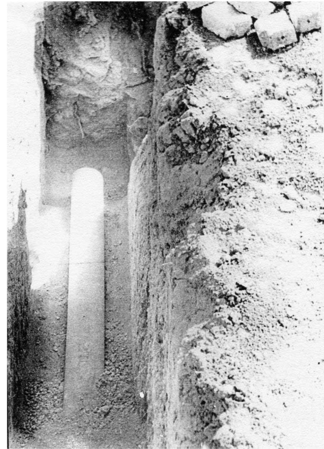
Рис. 4.29 б. Устьевая труба опытной дрены
