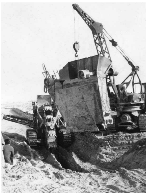
Рис. 1.18. Перемещение дренажного устройства с демонтажем бункера
