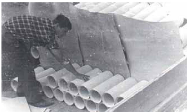
в) опытная партия труб с фасками на погрузке для отправки на объект строительства
