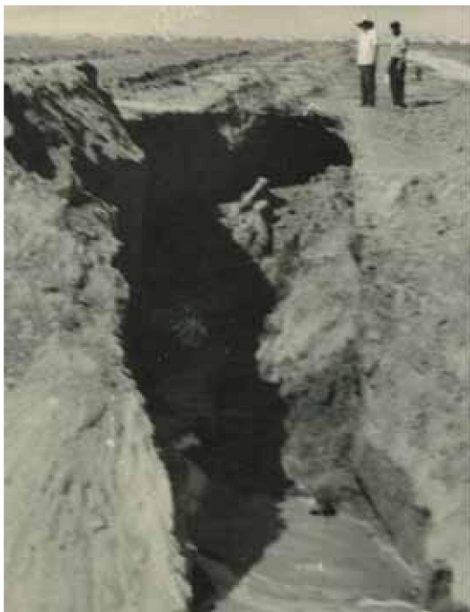
Рис. 2.4. Ирригационные эрозии приустьевой части дрен
