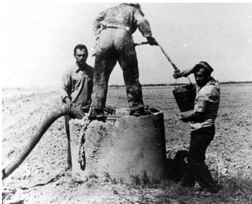
Рис. 3.27. Очистка смотровых колодцев бригадой рабочих
