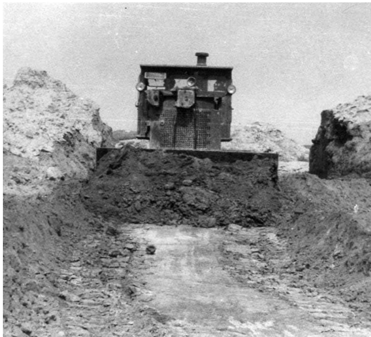
Рис. 1.21. Подготовка трассы дренажника под заданный уклон дрены бульдозерами
