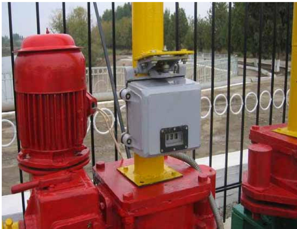
Рис. 4. Установка ДПЗ на винт затвора
