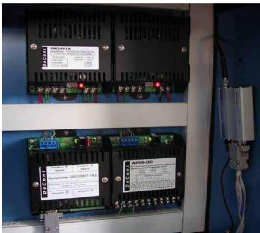
Рис. 9. Установка модема Wavecom MI306B
