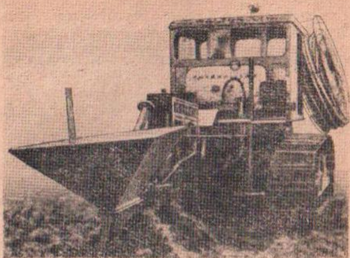
Рис. 36. Дреноукладчик пластмассового дренажа с фильтрующей засыпкой для осушения тяжелых почв.
