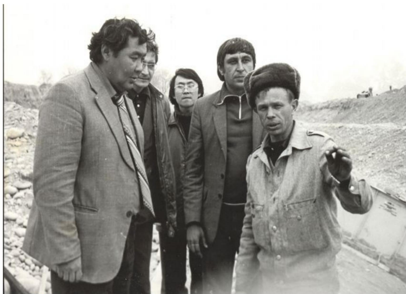
Байузаков Бермес Хасенович на строительстве Большого Алматинского Канала имени Д.А.Кунаева
