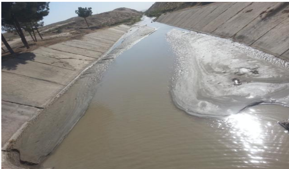
Рисунок 1 – Верхний и нижний бьефы подводящего канала Актепинского водохранилища.
