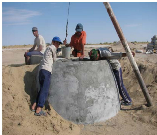
Рисунок 9 – Выемка песка из колодца слоем 1 м
