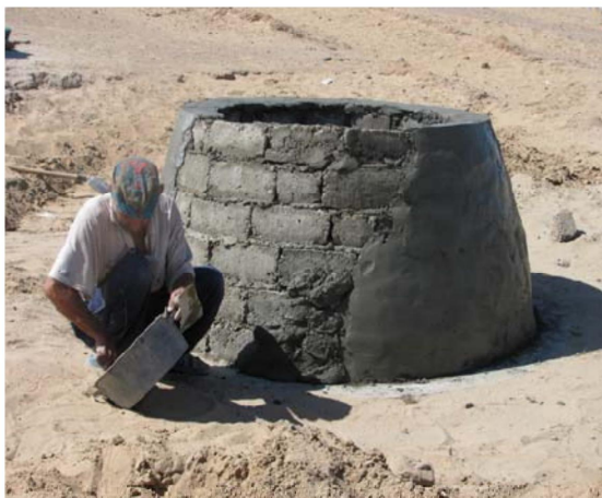
Рисунок 8 – Подготовка внешнего свода колодца
