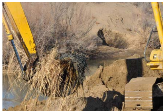
Рисунок 4 – Очистка коллектора от камыша
