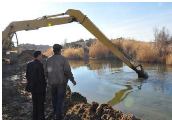
Рисунок 3 – Углубление русла коллектора
