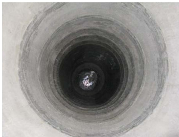
Рисунок 11 – Появление воды на глубине 18–20 м
