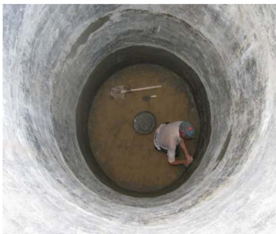
Рисунок 10 – Бетонирование каждого слоя. Для бетонирования используется 6-мм арматура
