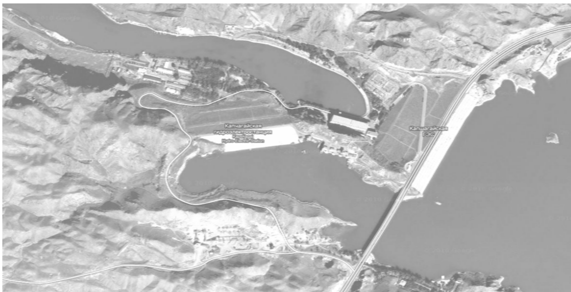
Рис. 1. Космический снимок гидротехнические сооружения Капчагайской ГЭС.
