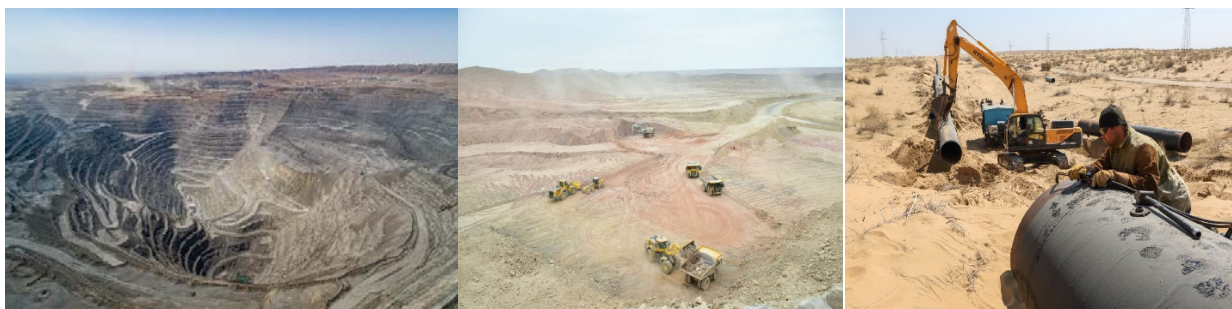
Изображения инфраструктуры хвостохранилища ГМЗ-7 на разных стадиях строительства (источник: официальный сайт АО «НГМК»)
