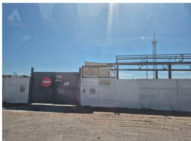
2-насосная станция «Пистали»
