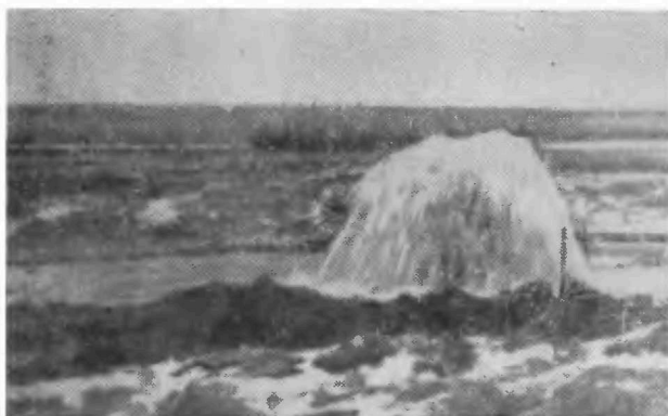
Рис. 37. Донгустау. Самоизлив воды из скважины с глубины 300 м. Альб. Дебит 20 л/сек. (Фото А. В. Сотникова)
