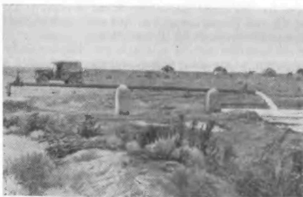
Рис. 38. Донгустау. Временный водопойный пункт у артезианской скважины. Устье зацементировано, установлен водорегулятор. (Фото А. В. Сотникова)
