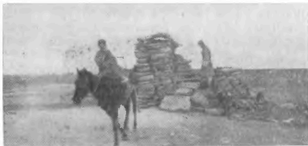
Рис. 68. Колодец на плато Устюрт глубиной 30 м. Для подъема воды используется тягловая сила — лошади, верблюды. (Фото А. В. Сотникова)
