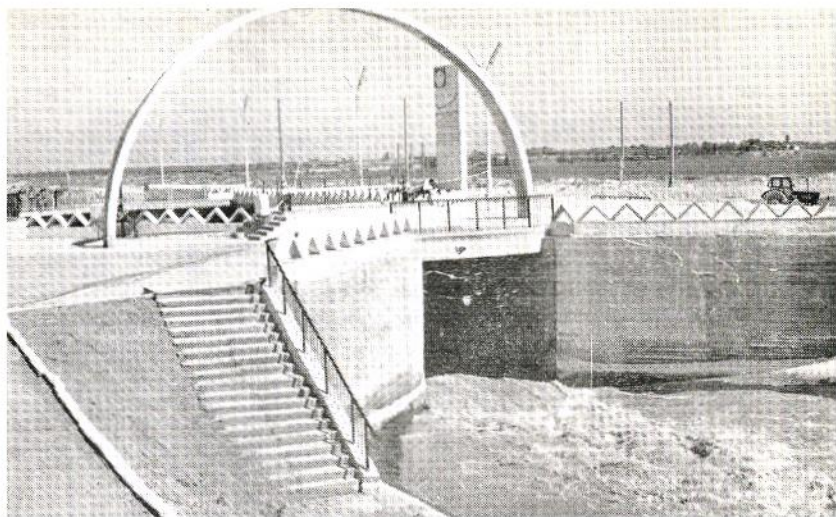
Кызылтюбинский (концевой) узел сооружений The Kizil'tyube failproof check structure Ensemble (terminal) d'ouvrages de Kyzyl'tioubé
