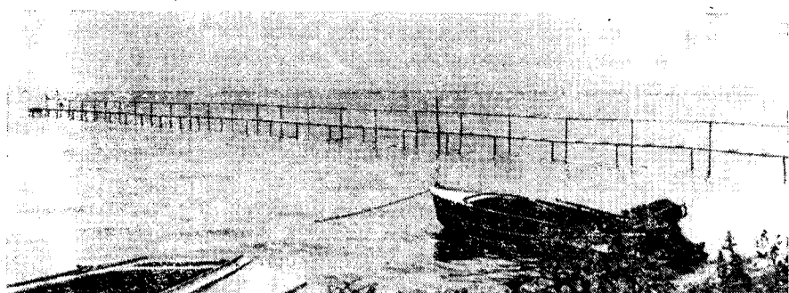
Рис. 7.1. Временная эстакада, построенная на Кременчугском водохранилище для изучения динамики береговой зоны (общая длина 80 м, наибольшая глубина 2,2 м).
