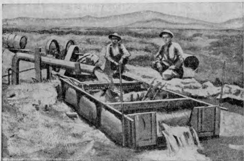
Рис. 48б. Складной водомер (по Мейнцеру и Кельтону).
