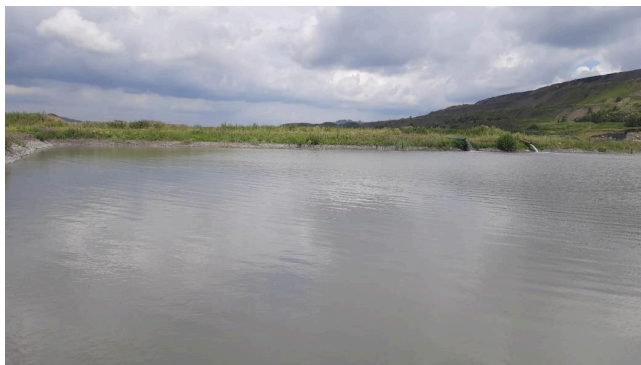
Рис. 1. Общий вид приемного резервуара очистных сооружений
