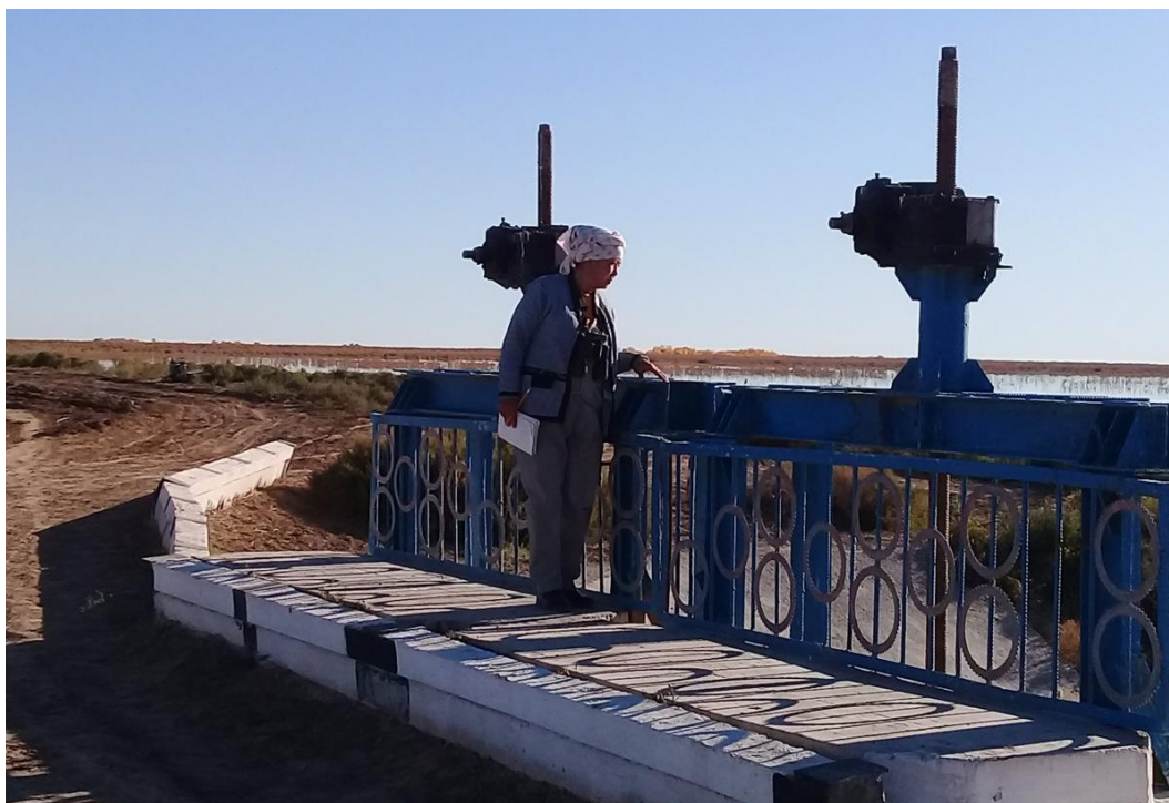
Рисунок 26. Осмотр возле Сооружения на озере Сарбас
