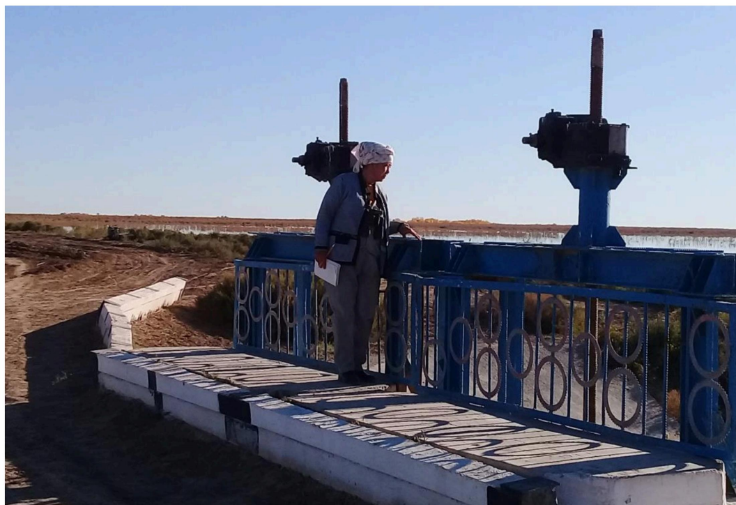
Рисунок 26. Осмотр возле Сооружения на озере Сарбас
